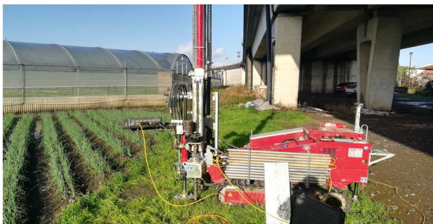
Figura 31 – Esecuzione prova CPT in sito
