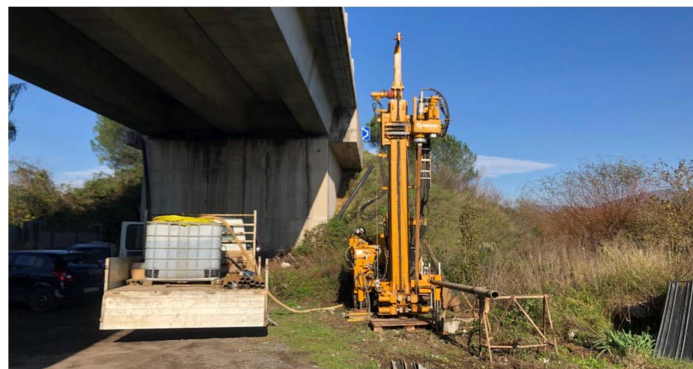
Figura 29 – Esecuzione di un sondaggio geognostico in sito
