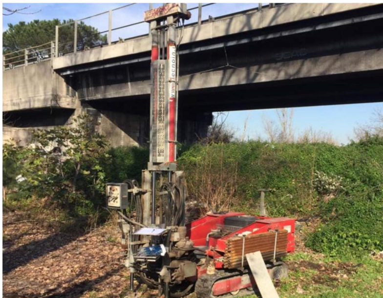
Figura 39 – Esecuzione prova DPSH in sito
