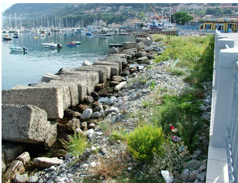
Via Cristoforo Colombo - vista da ovest verso est
