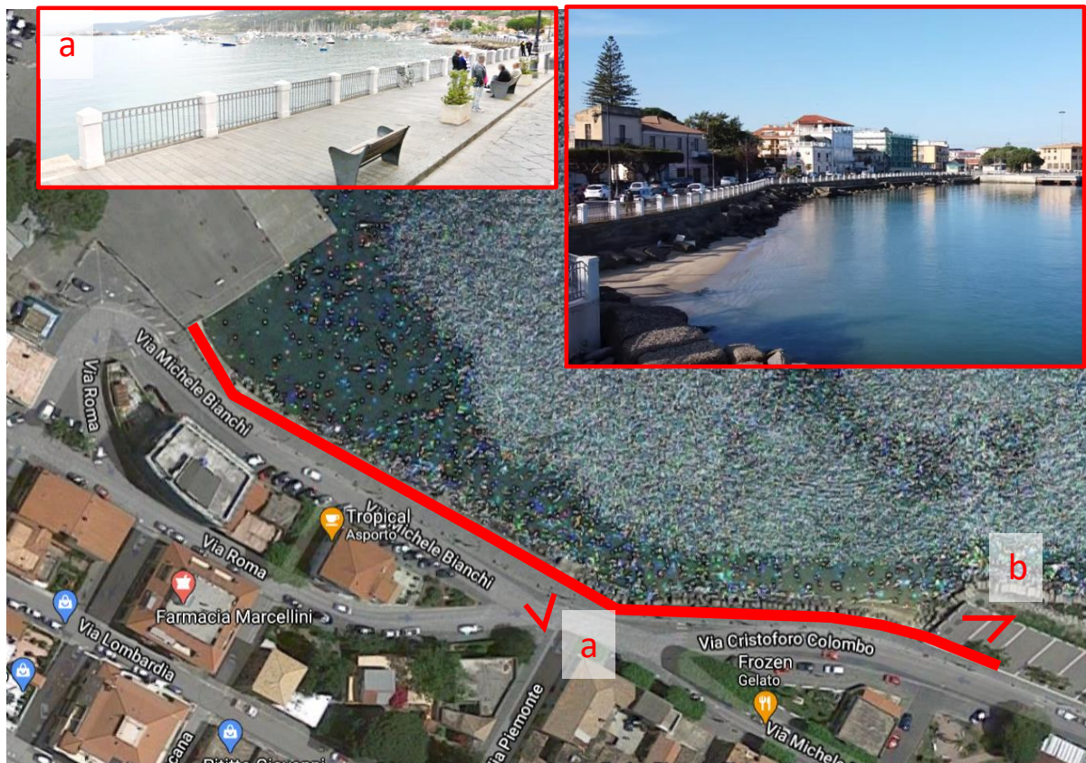
Figura 35: stato attuale del sito oggetto d'intervento
