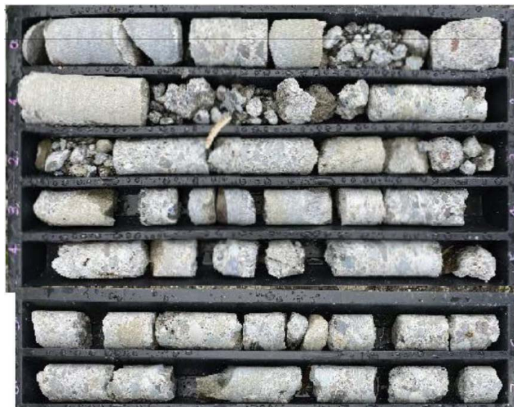
Fig. 4-2: Calcestruzzo pila 6, Sondaggio S2, da 0 a 7 m, (Geotecnica Palazzi-Giomarelli srl, 2020)
