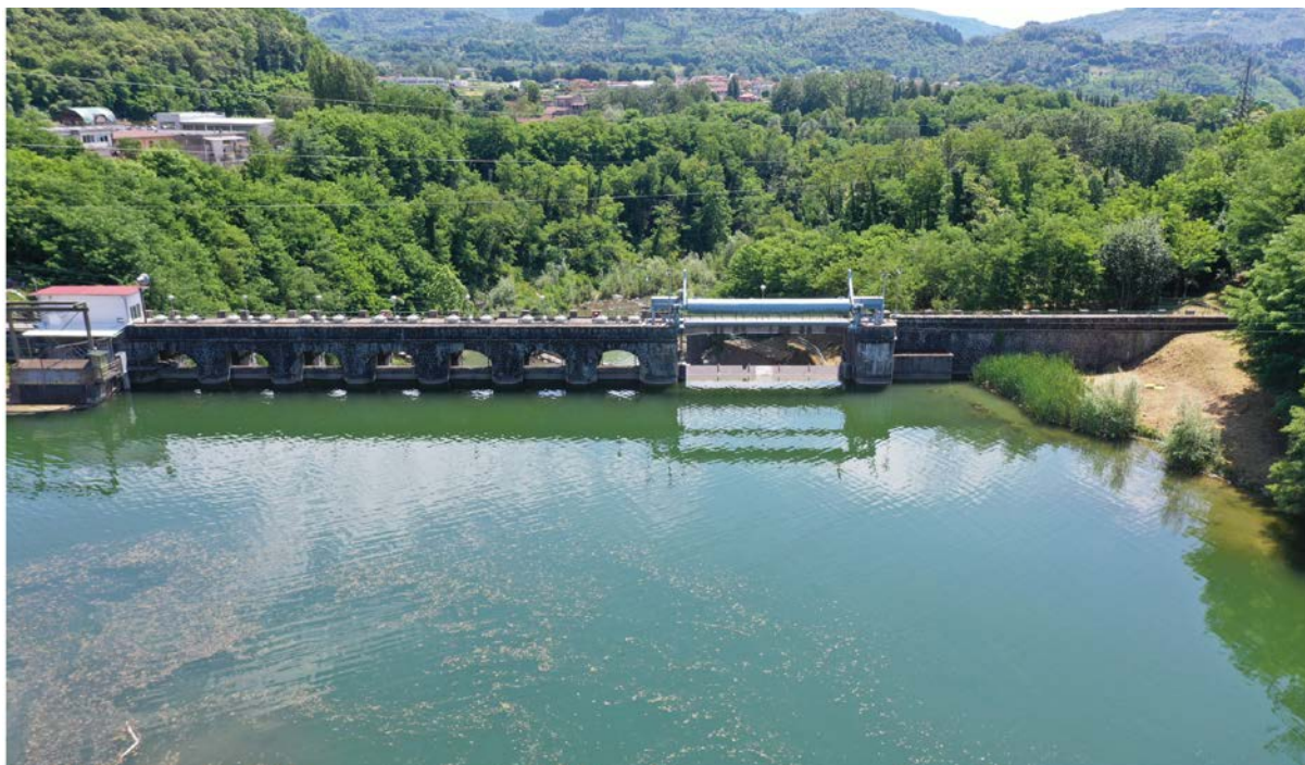
Fig. 3-1: Foto del serbatoio della diga (SP, 2020, foto drone)
