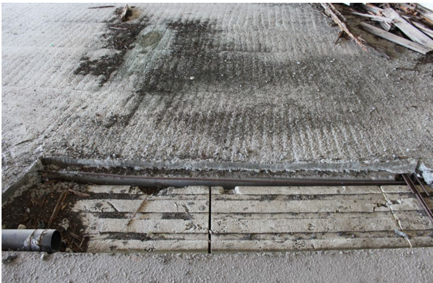
47. Dettaglio solaio interpiano est
