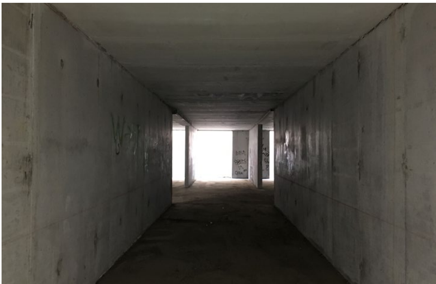
22. Vista struttura piano terra
