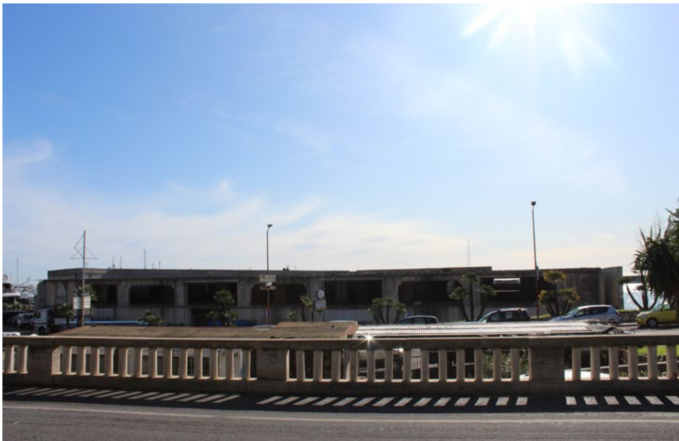
3. Vista da Passeggiata Salvo D'Acquisto Il prospetto nord dell'edificio è interamente visibile dalla passeggiata ciclo-pedonale.
