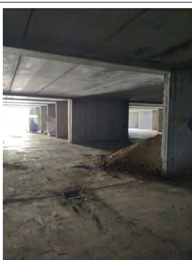
Figura 21. Locali al piano terra – Blocco A.
