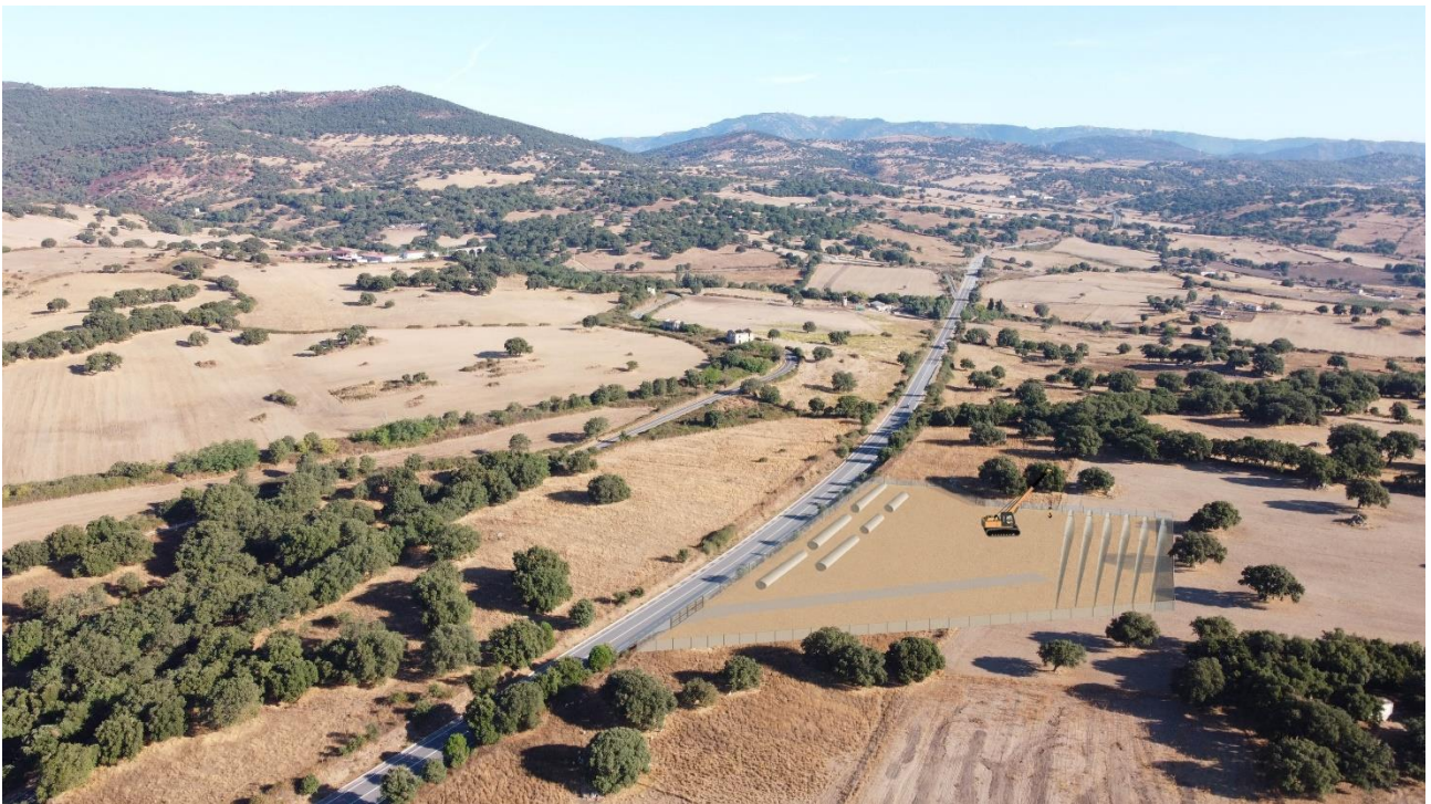
Figura 4.1 – Area di trasbordo in fase di cantiere
