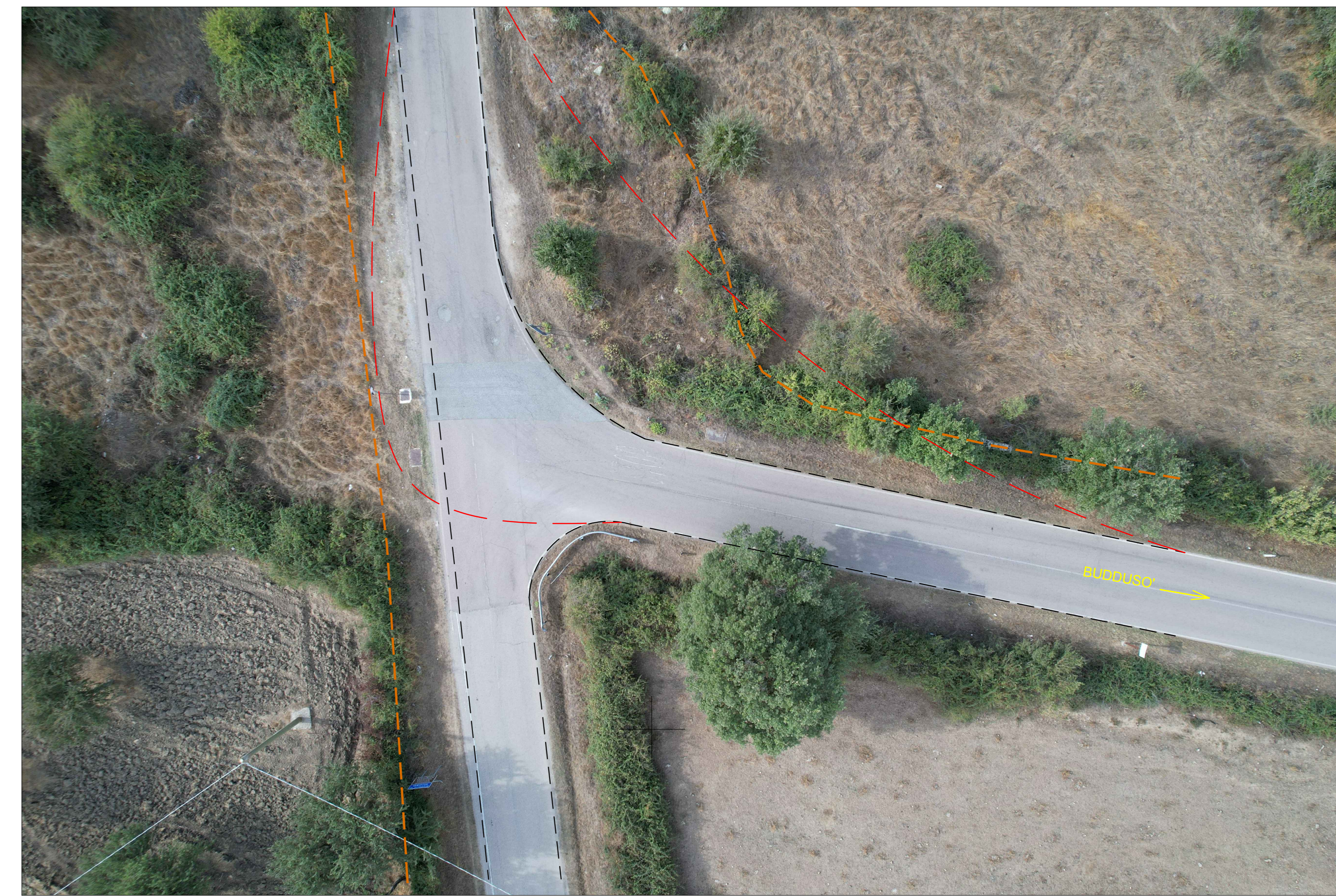
ALLARGAMENTO SU STRADA PROVINCIALE
