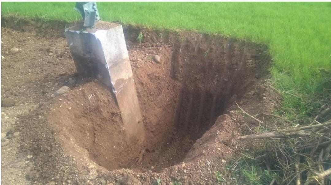
**Figura 40 - Esempio rimozione della fondazione superficiale di un sostegno 380 kV ST (fonte: Terna spa)**
