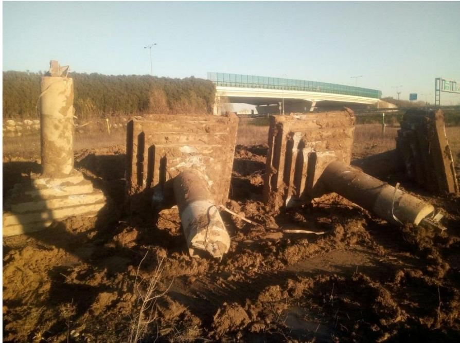
**Figura 39 - Esempio di rimozione della fondazione superficiale di un sostegno 220 kV (fonte: Terna spa)**
