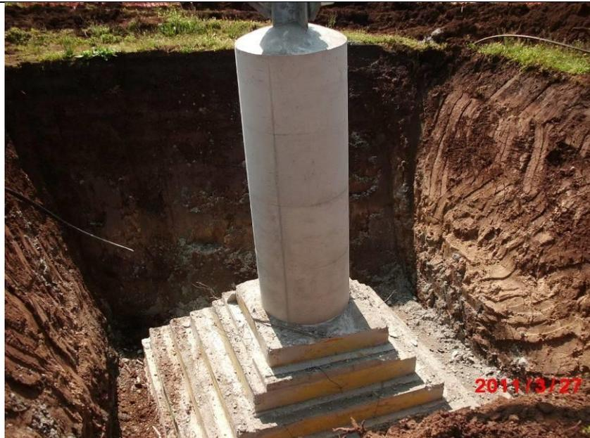
**Figura 13 - Realizzazione di fondazioni superficiali tipo CR per un sostegno a traliccio.**
