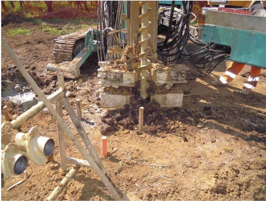
**Figura 26 - Macchina operatrice per la realizzazione di micropali tubfix; sistema di scavo mediante trivella elicoidale (fonte: Terna spa)**
