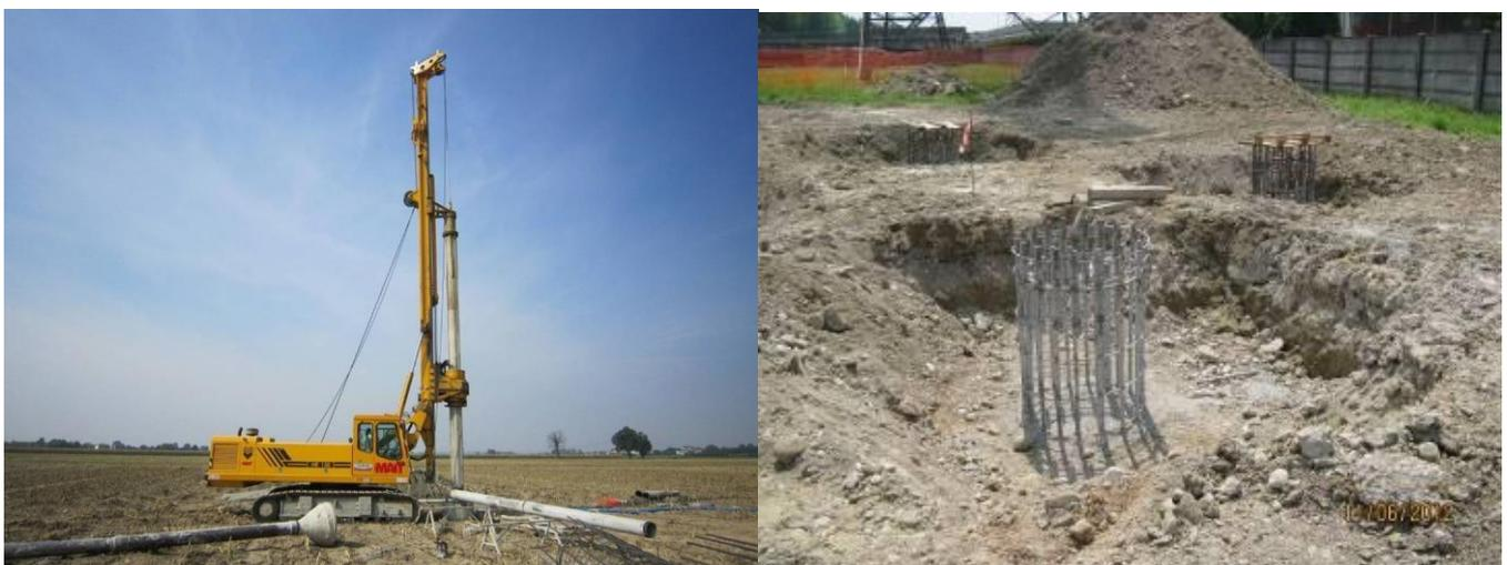
**Figura 21 - Macchina operatrice per la realizzazione di pali trivellati (fonte: Terna spa)**
