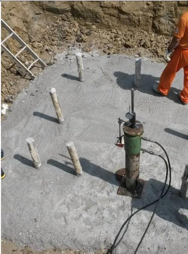
**Figura 27 - Realizzazione di micropali tipo tubfix per un sostegno a traliccio; si possono osservare i 9 micropali già realizzati ed iniettati; in questa fase, prima dell'armatura e cassetatura del plinto di fondazione, si sta eseguendo una prova di tenuta del micropalo allo strappamento, al fine di verificare la corretta progettazione e realizzazione dello stesso(fonte: Terna spa)**
