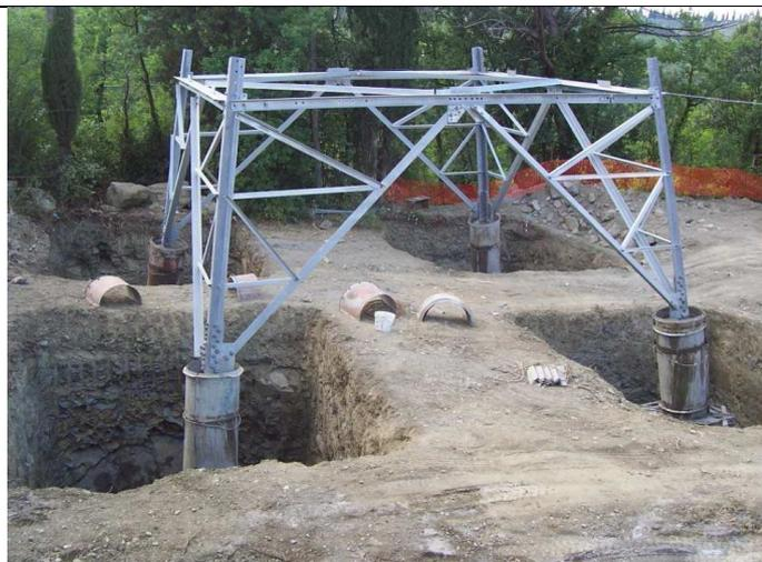
**Figura 14 - Realizzazione di fondazioni superficiali tipo CR per un sostegno a traliccio.**
