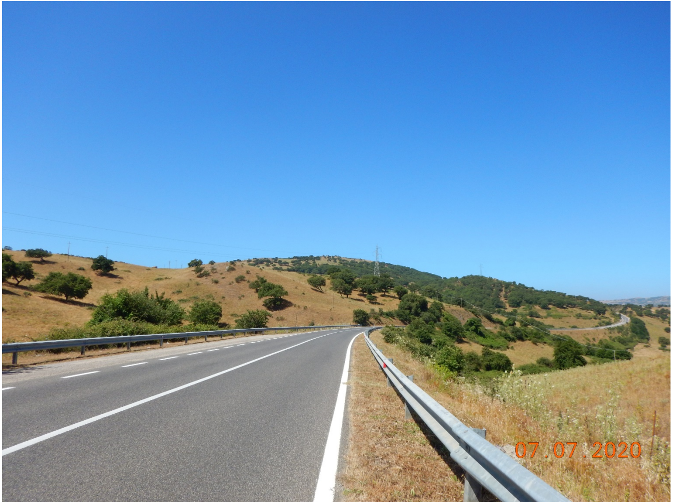
Punto di vista sostegno 36N(ante operam)
