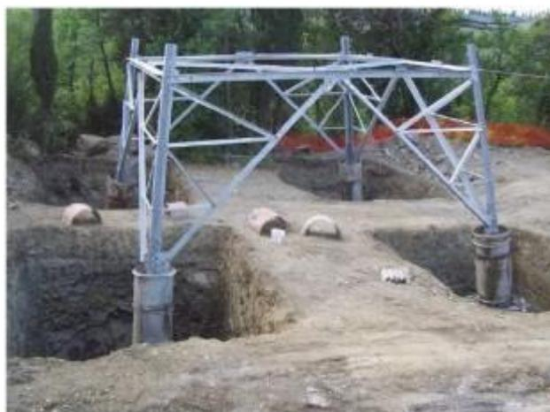
Fig. 1 – Scavo per il posizionamento dei plinti
