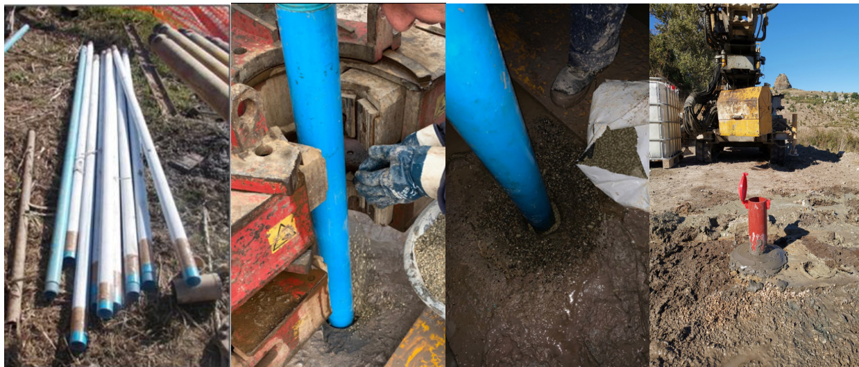
Figura 8: Installazione piezometro e terminale protezione metallico
