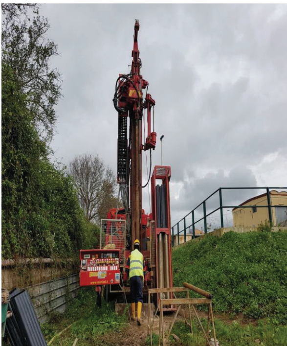
Postazione SONDAGGIO S1
