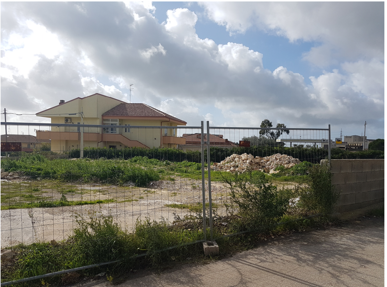
Foto 1: Area di cantiere AS.04
