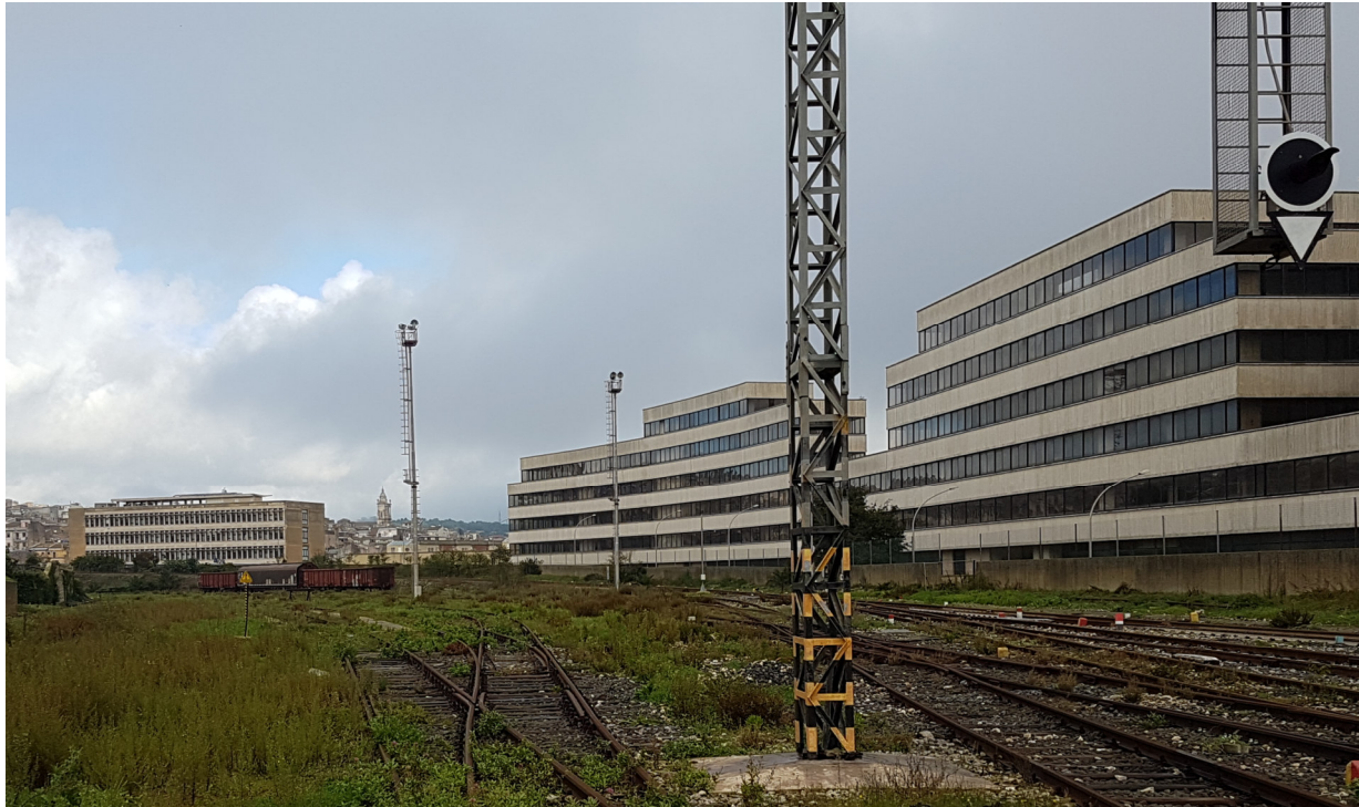
Foto 1: Vista dell'area di cantiere
