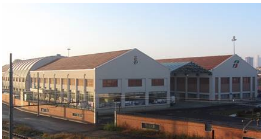
Figura 7 – Posto Centrale Milano Greco Pirelli.
