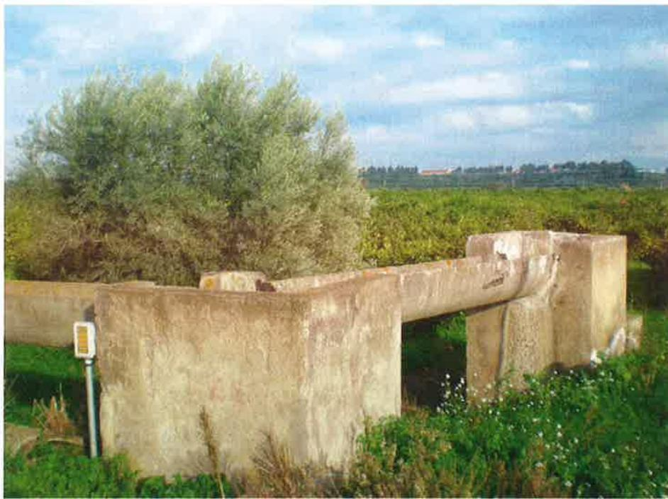
**Figura 25** – Canale irriguo in attraversamento con sifone
