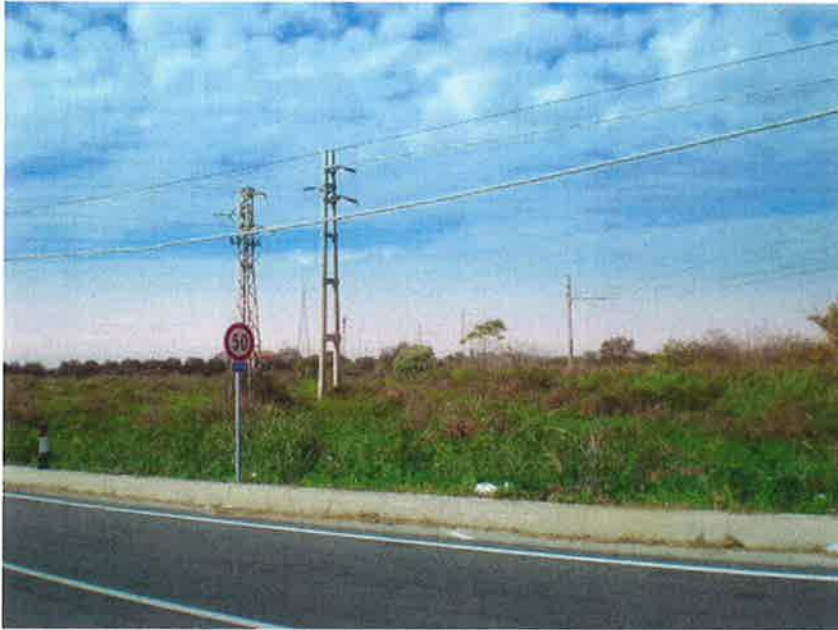
Figura 41 – Rete elettrica che attraversa la futura ferrovia
