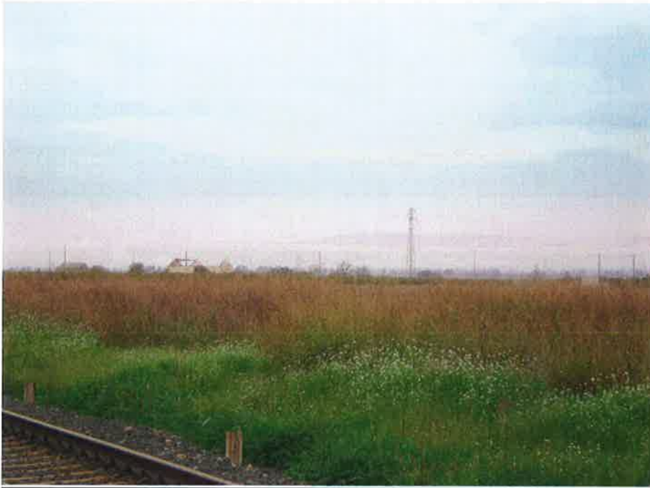
Figura 19 - Rete elettrica che attraversa la ferrovia
