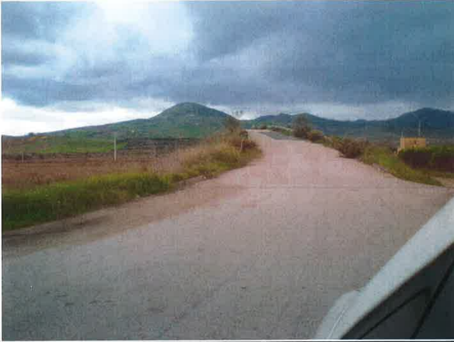
Figura 7 – Rete elettrica a sud della ferrovia
