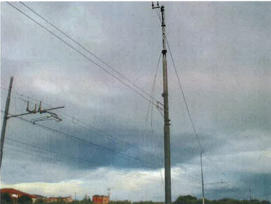
Figura 12 – Rete elettrica che attraversa la ferrovia
