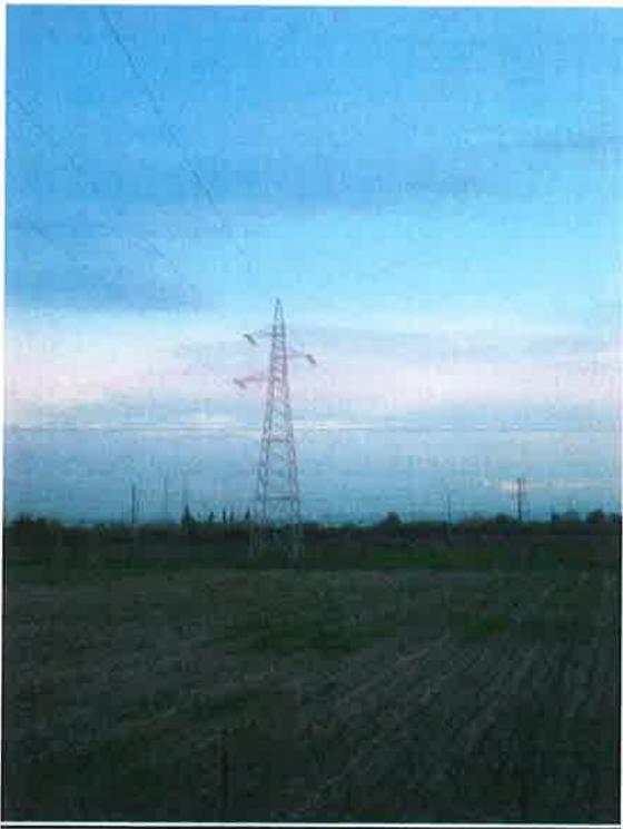
Figura 35 – Rete elettrica che attraversa la ferrovia
