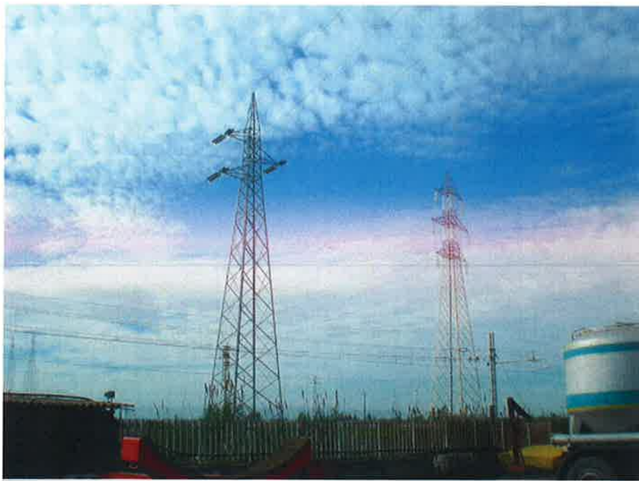
Figura 37 – Rete elettrica che attraversa la ferrovia
