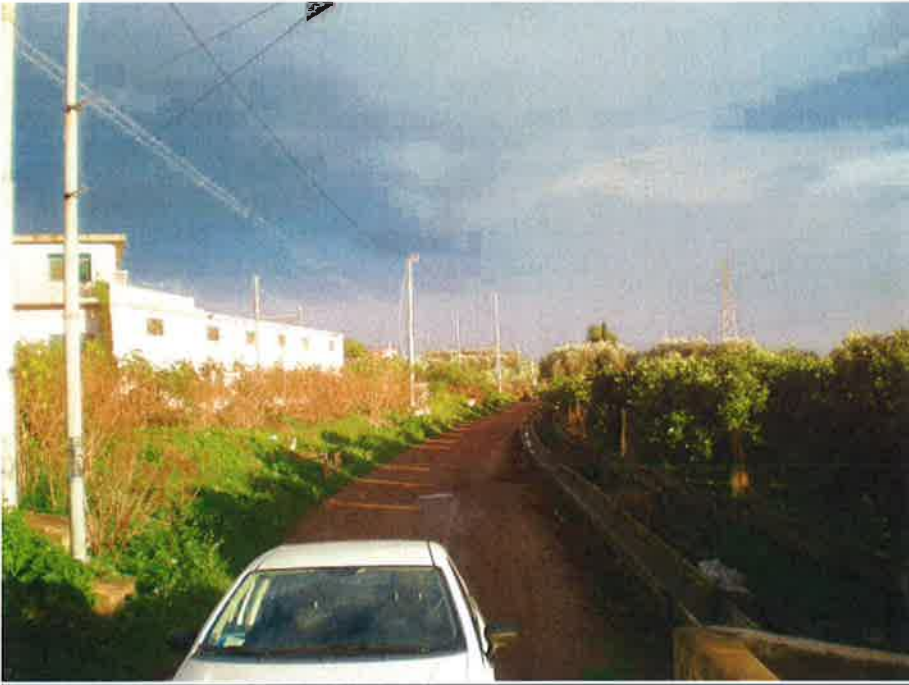
Figura 11 – Rete elettrica che attraversa la ferrovia
