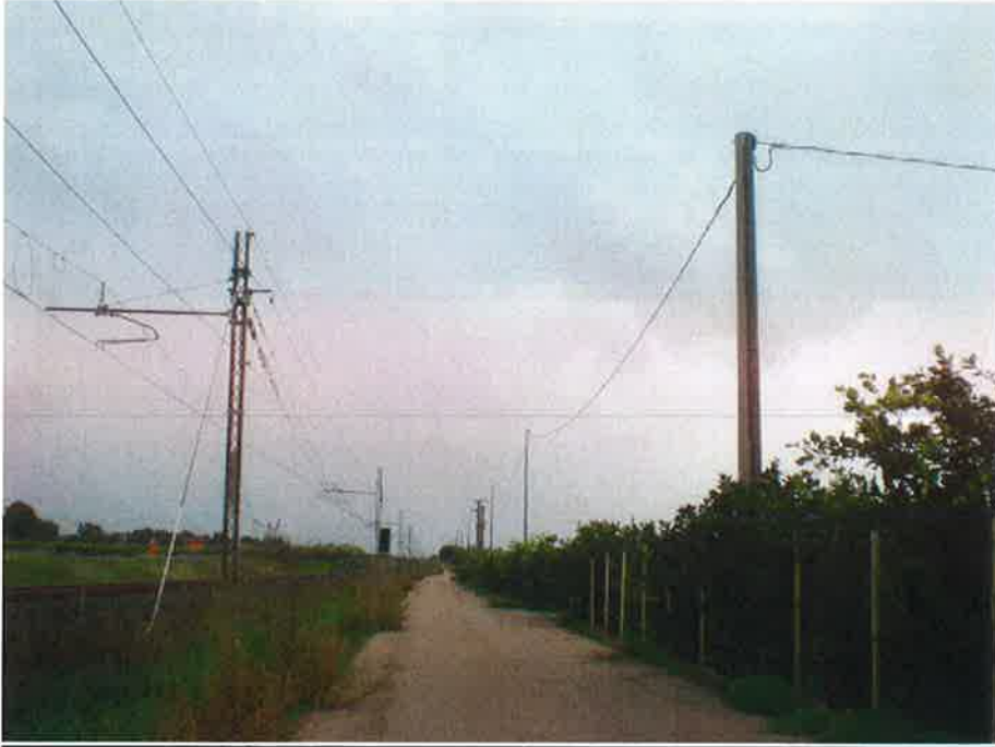
Figura 3 – Rete elettrica a sud della ferrovia
