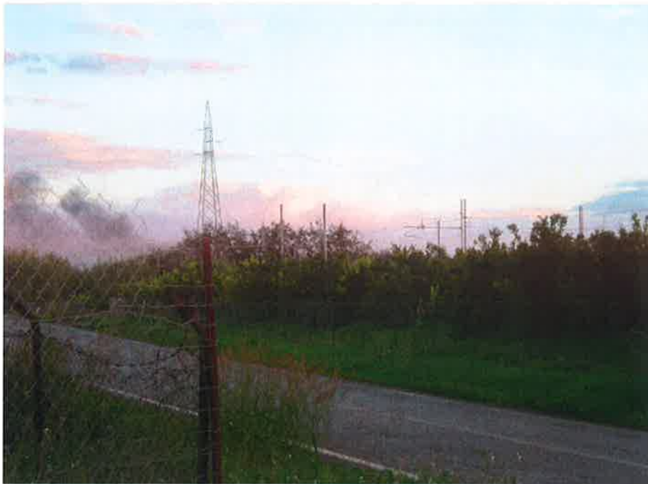
Figura 17 – Rete elettrica che attraversa la ferrovia
