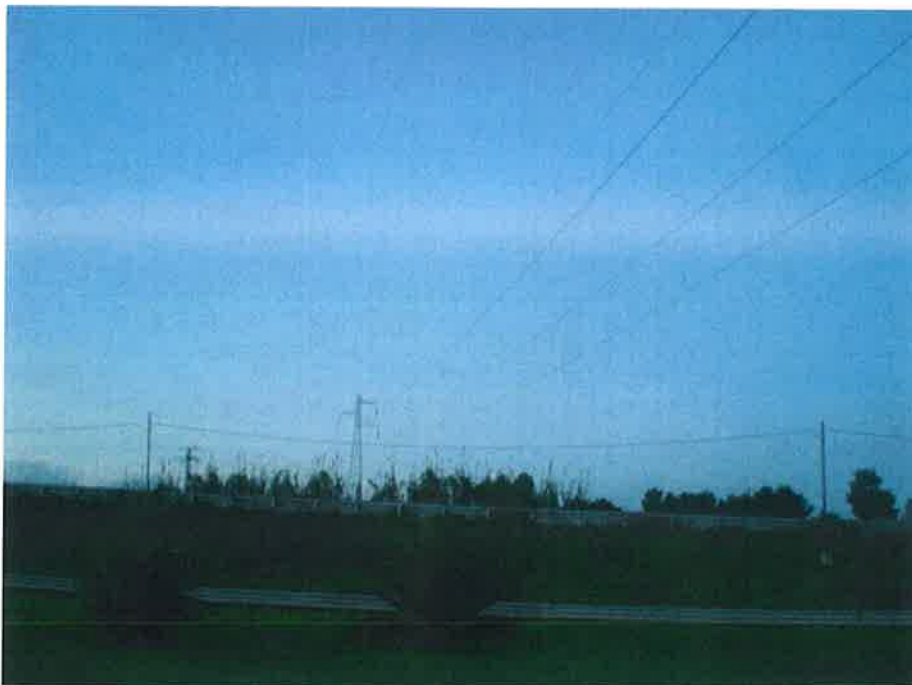
Figura 36 – Rete elettrica che attraversa la ferrovia
