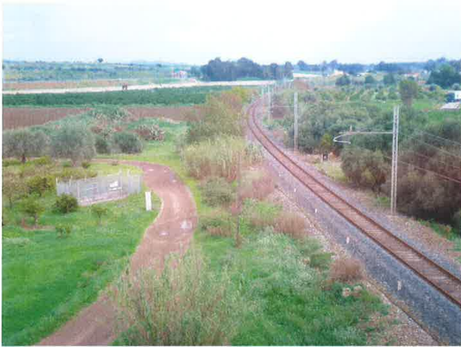
Figura 29 – Rete elettrica che attraversa la ferrovia
