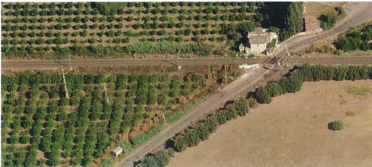
Figura 44 – Rete elettrica che attraversa la futura ferrovia
