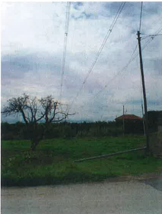
Figura 26 – Rete elettrica che attraversa la ferrovia
