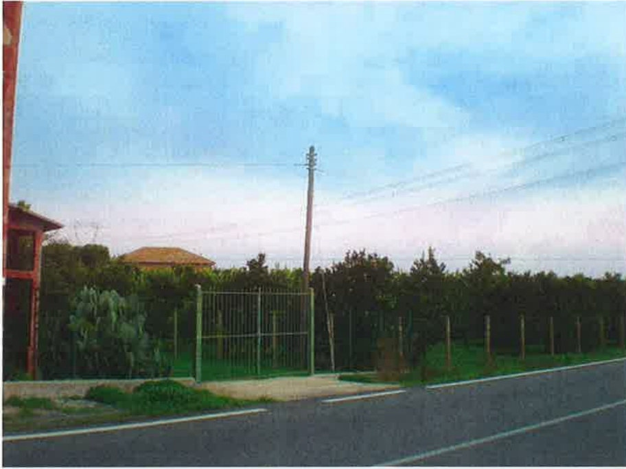
Figura 25 – Rete elettrica che attraversa la ferrovia
