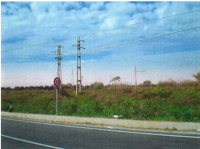
Figura 43 – Rete elettrica che attraversa la futura ferrovia
