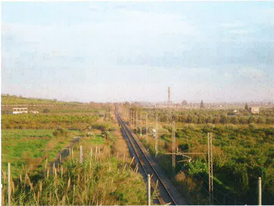
Figura 33 – Rete elettrica che attraversa la ferrovia
