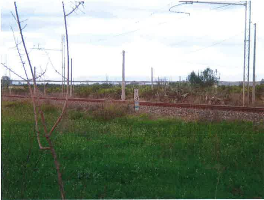
Figura 23 – Rete elettrica a sud della ferrovia
