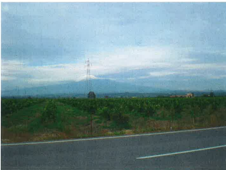
Figura 28 – Rete elettrica che attraversa la ferrovia
