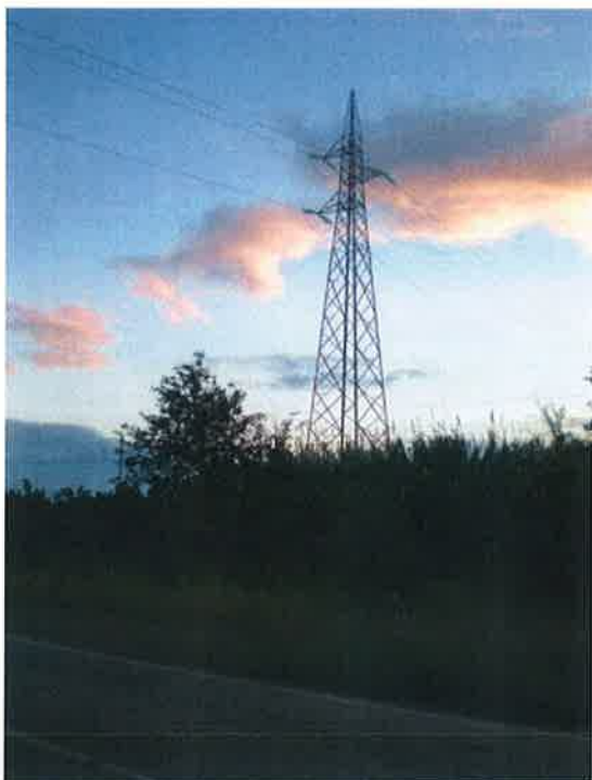
Figura 18 – Rete elettrica che attraversa la ferrovia
