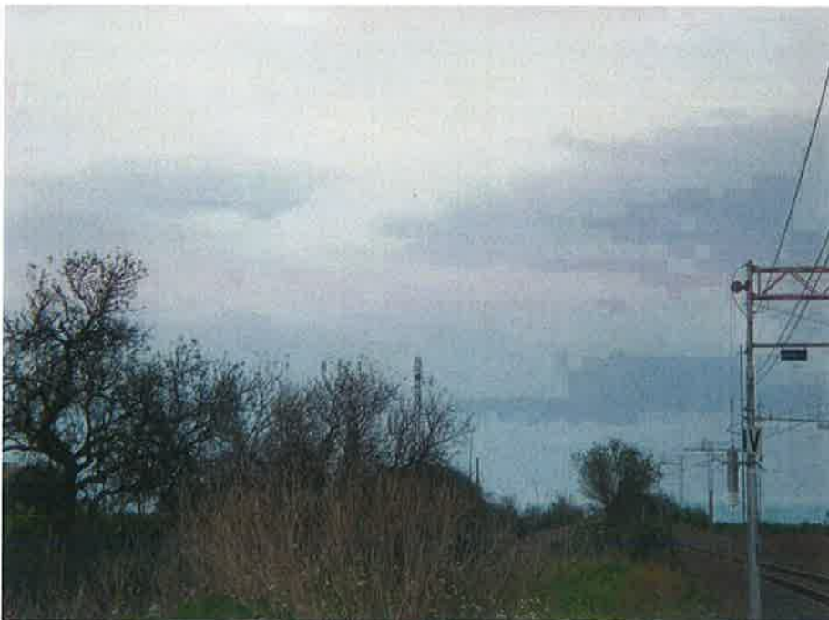
Figura 20 - Rete elettrica che attraversa la ferrovia
