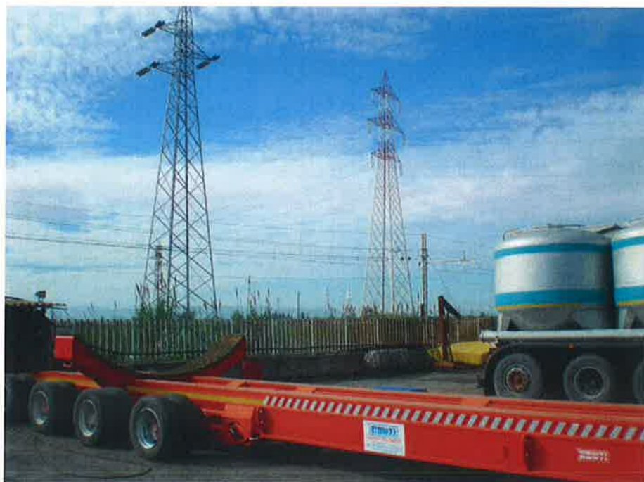
Figura 38 – Rete elettrica che attraversa la ferrovia
