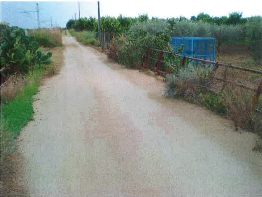
Figura 4 – Rete elettrica a sud della ferrovia
