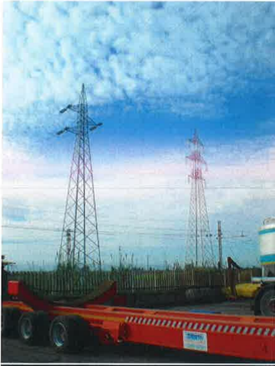
Figura 39 – Rete elettrica che attraversa la ferrovia
