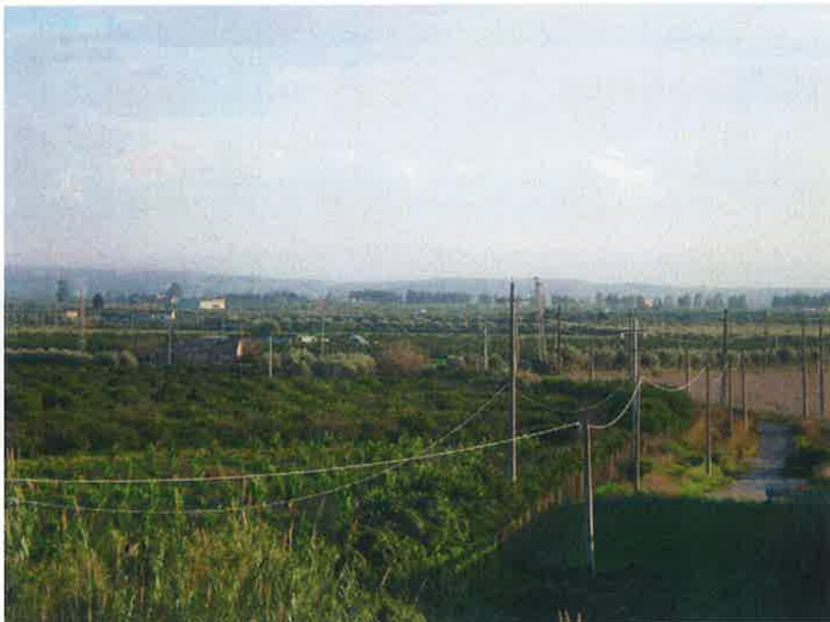
Figura 34 – Rete elettrica che attraversa la ferrovia
