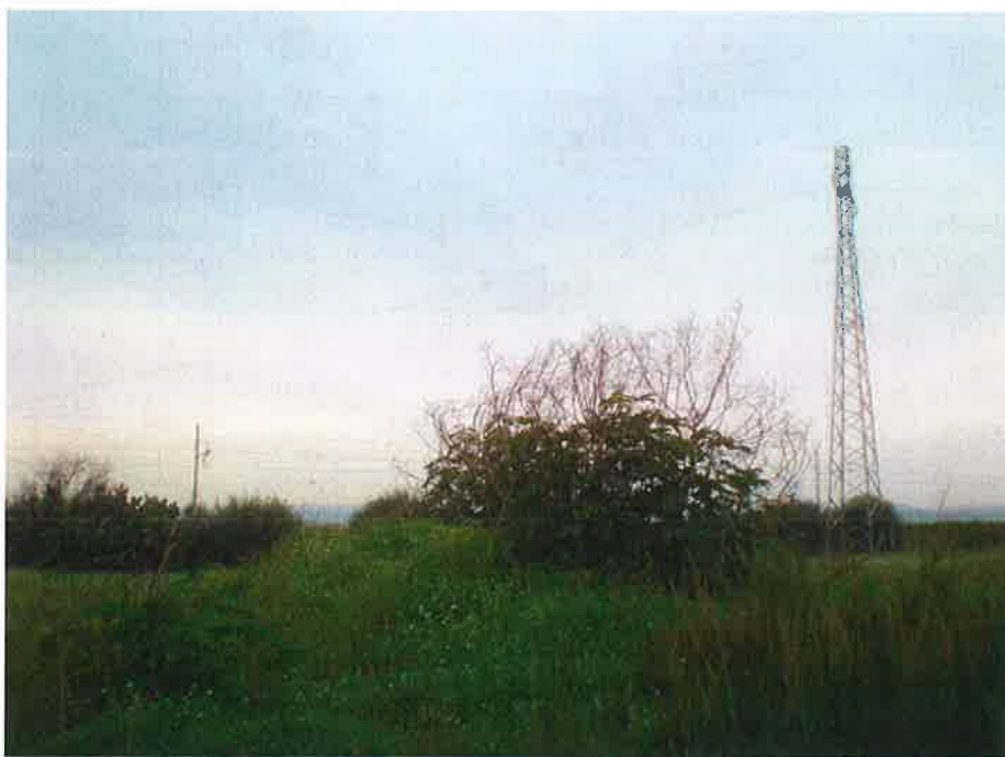
Figura 21 – Rete elettrica che attraversa la ferrovia
