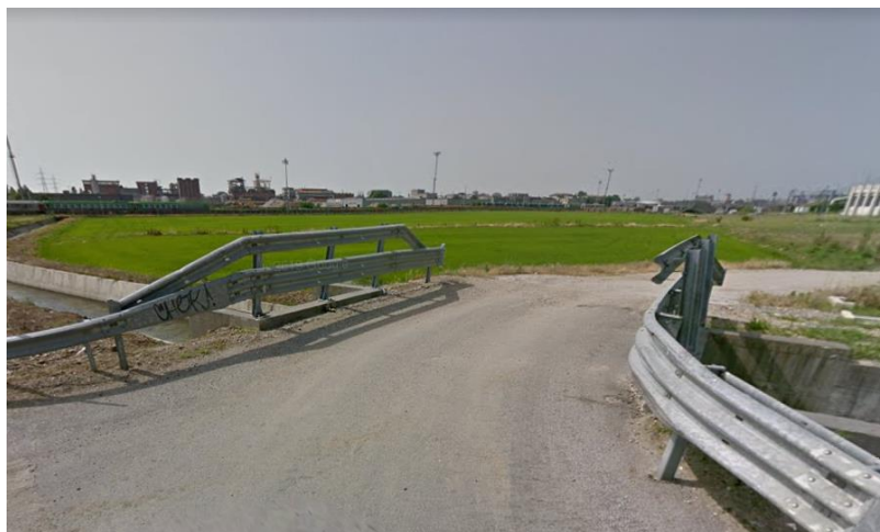
Accesso area di cantiere
