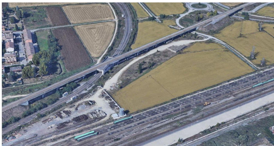
Vista sull'area di cantiere
