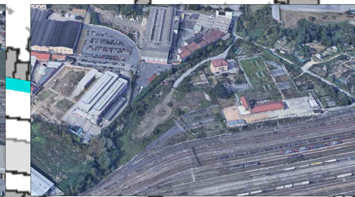
Figura 2 - Vista dell'area di intervento
