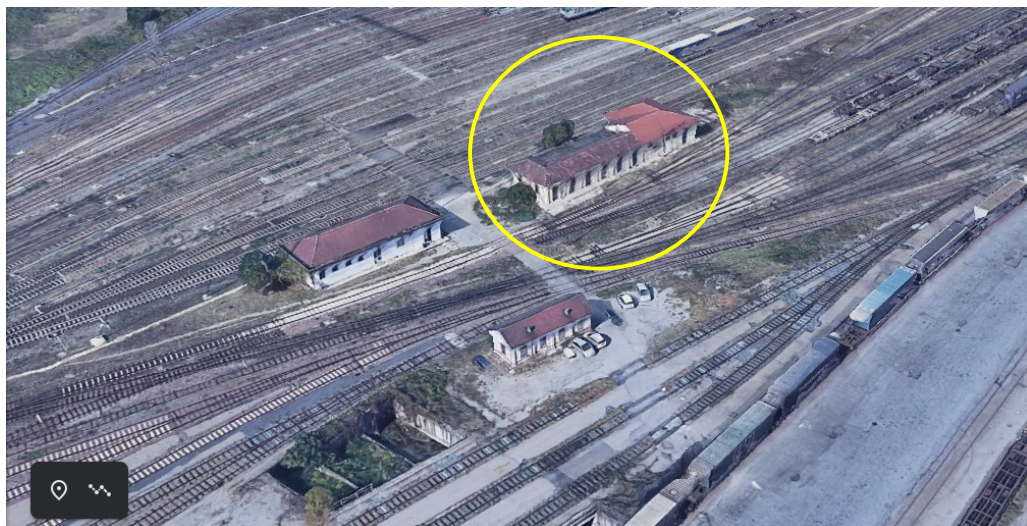
Fig. 7 - Vista dall'alto Fabbricato DE01B
