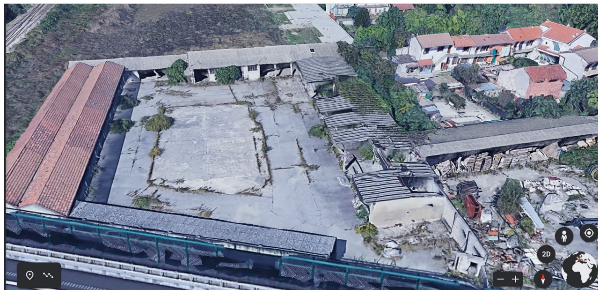
Fig. 3 - Vista lato autostrada - Fabbricato DE01A
