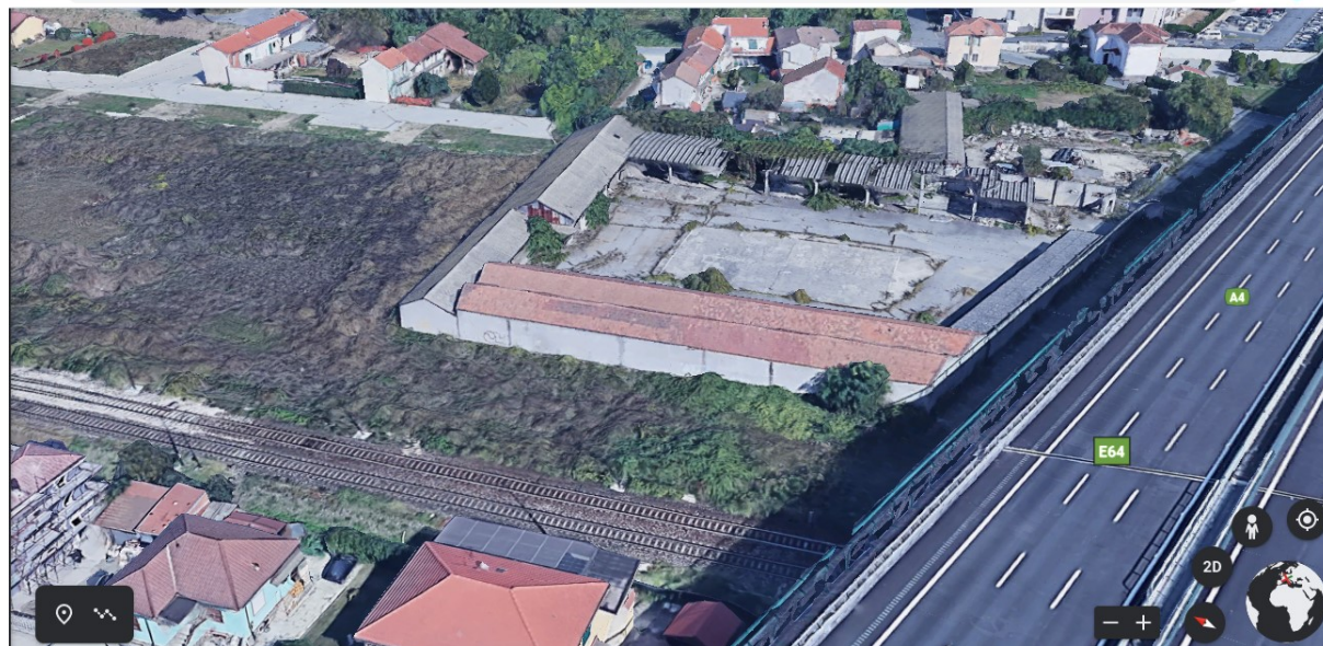
Fig. 2 - Vista laterale - Fabbricato DE01A
