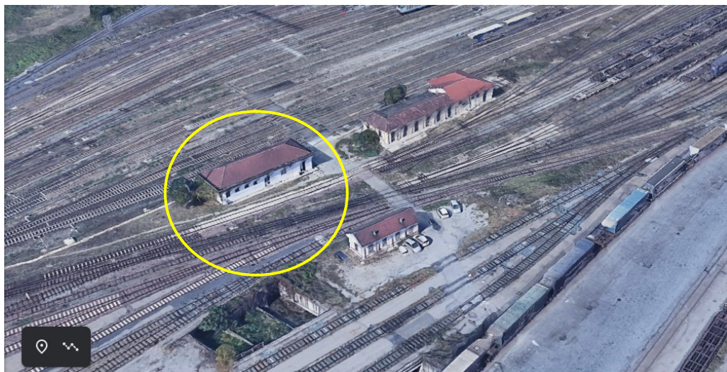
Fig. 5 - Vista dall'alto Fabbricato DE01B
