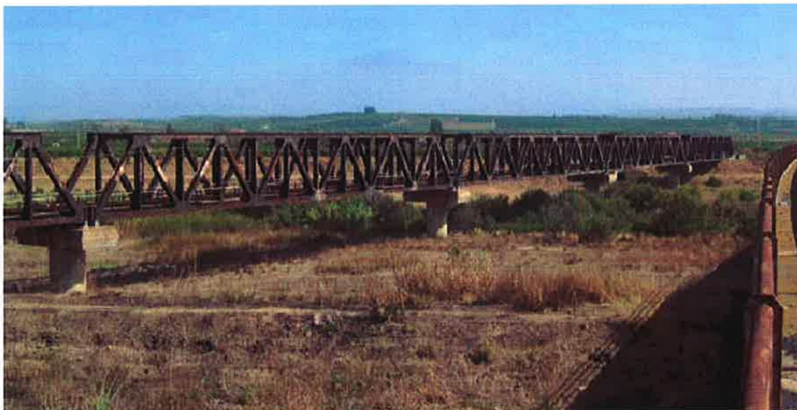
Figura 97 - Foto attraversamento ferroviario esistente sul Fiume Simeto.
