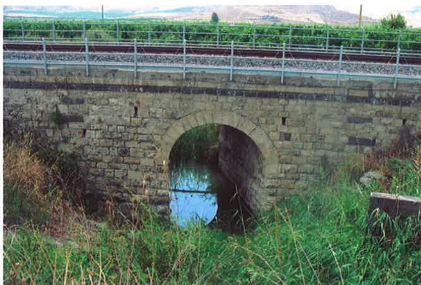
Figura 42 – Ponte ferroviario esistente - Vallone Fontana Murata.
