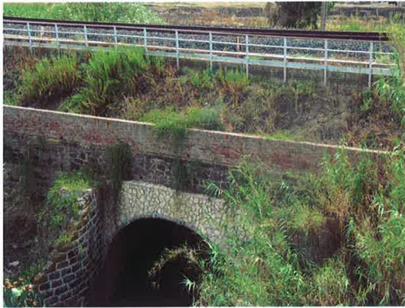
Figura 28 – Ponte ferroviario esistente - Vallone Aranciario.
