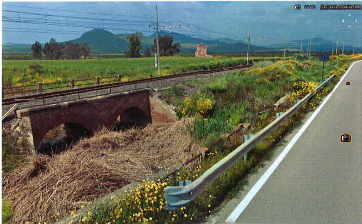
Figura 50 – Foto ponte stradale SS192 – Vallone Sferro.
