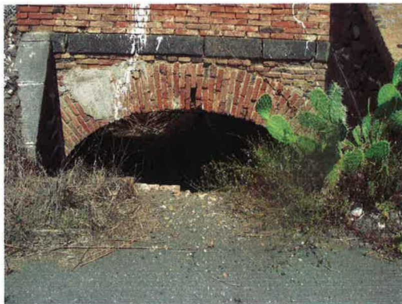
Figura 80 – Foto ponte ferroviario attuale – Vallone Alice Fontazza.
