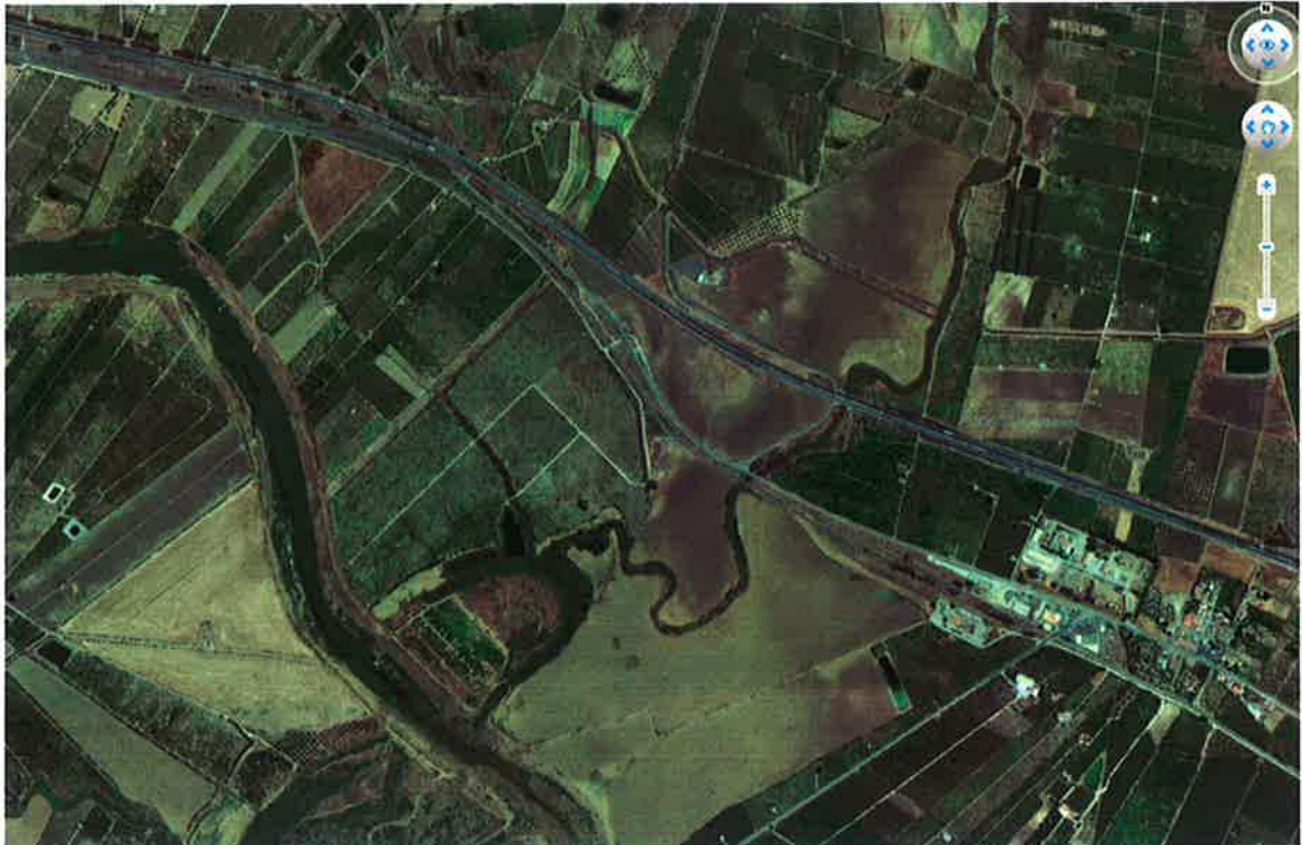
Figura 47 – Visione aerea dell'ubicazione geografica dell'area oggetto di studio – Vallone Sferro.
