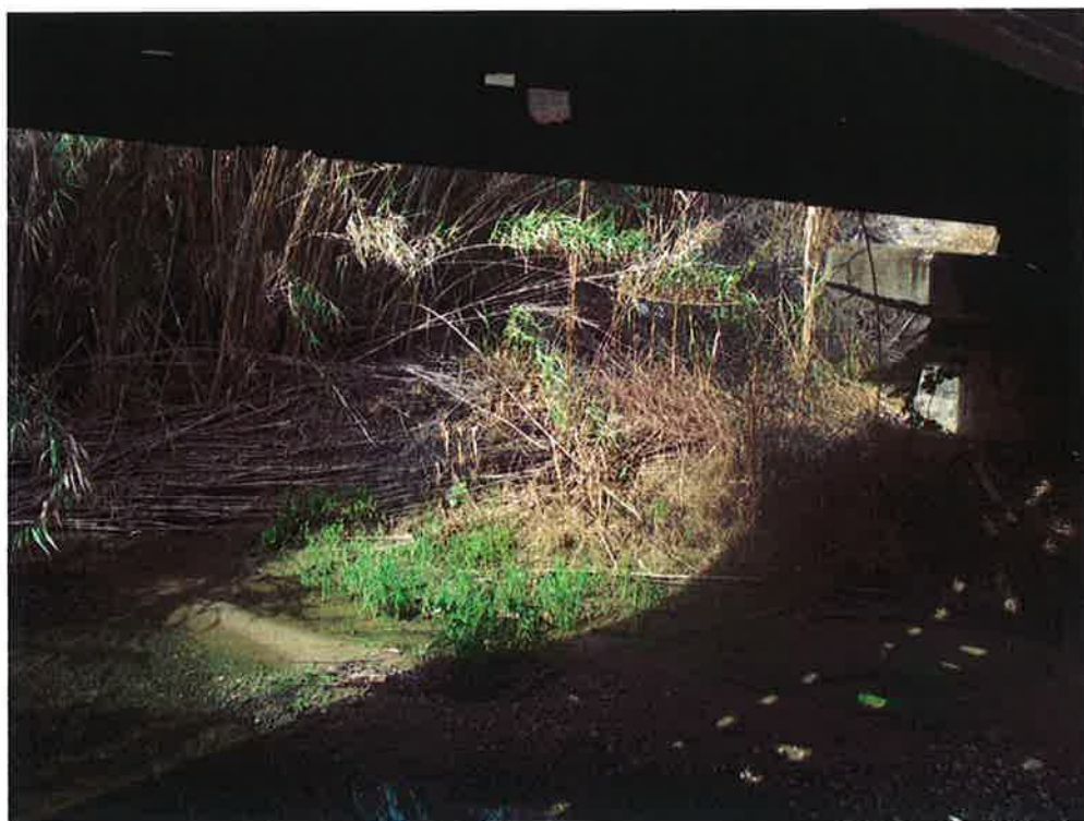
Figura 67 – Foto del sopraluogo – Torrente Finaita.
