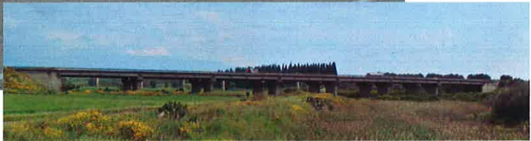
Figura 49 – Foto ponte autostradale A19 – Vallone Sferro.
