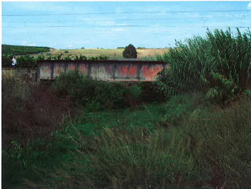
Figura 85 – Foto dell'alveo naturale durante il sopralluogo – Vallone Mendola.
