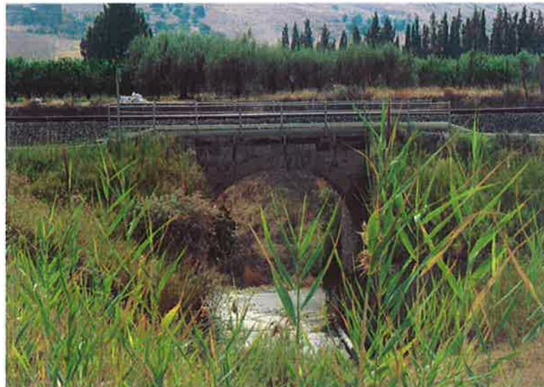
Figura 21 – Ponte ferroviario esistente - Vallone della Rosa
