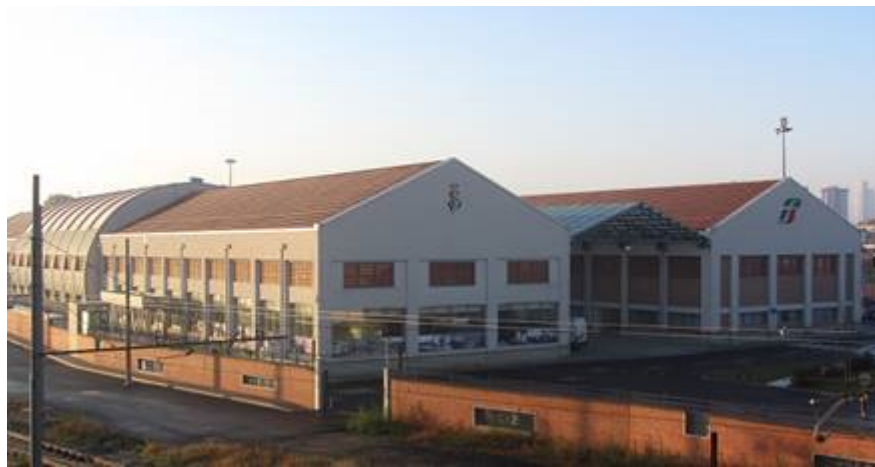
Figura 7 – Posto Centrale Milano Greco Pirelli.
