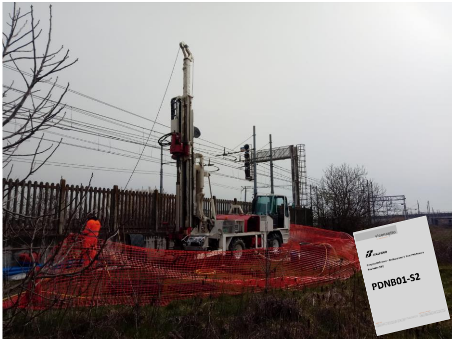
Figura 13 – Sonda approntata nel sondaggio PDNB01_S2
