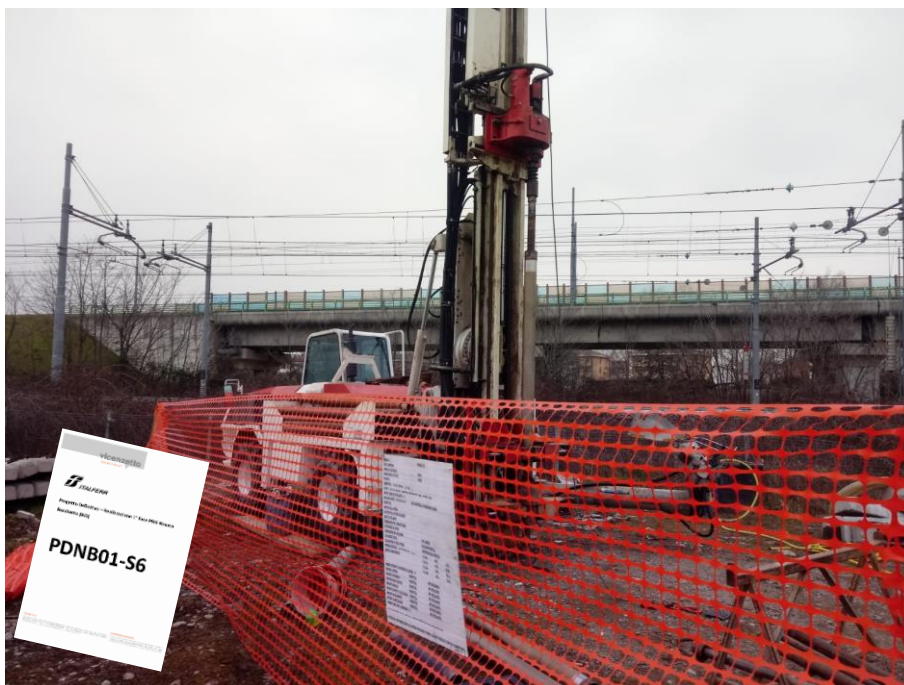
Figura 53 – Sonda approntata nel sondaggio PDNB01_S6
