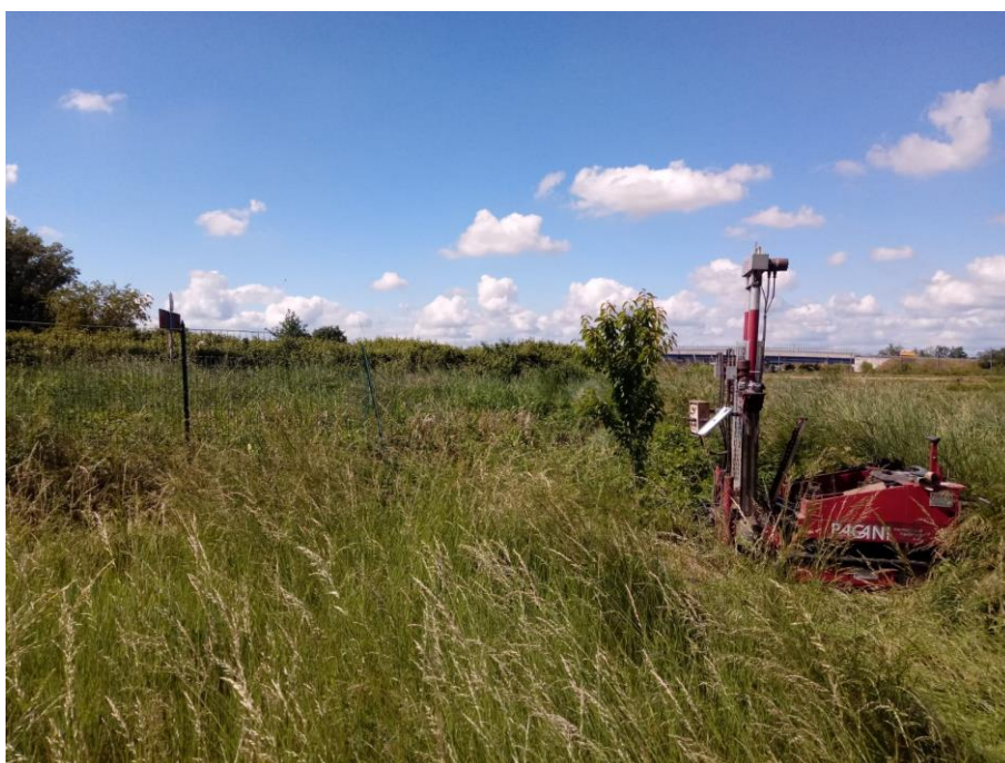
Figura 19 – Penetrometro approntato nella prova DPSH09
