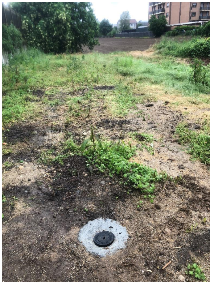
Figura 20 - Pozzetto protezione del tubo piezometrico posto nel sondaggio PDNB01_S2.
