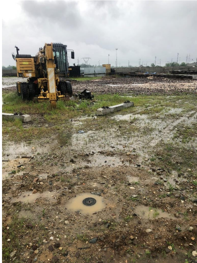
Figura 60 - Pozzetto protezione del tubo piezometrico posto nel sondaggio PDNB01_S6.
