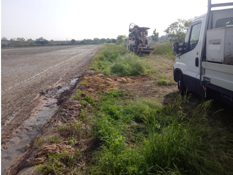
Figura 40- Ripristino area di lavoro Sondaggio PDNB01_S4
