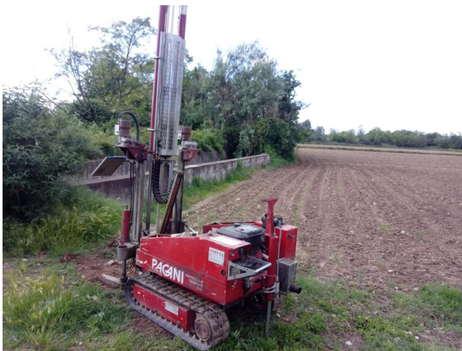
Figura 17 – Penetrometro approntato nella prova DPSH08
