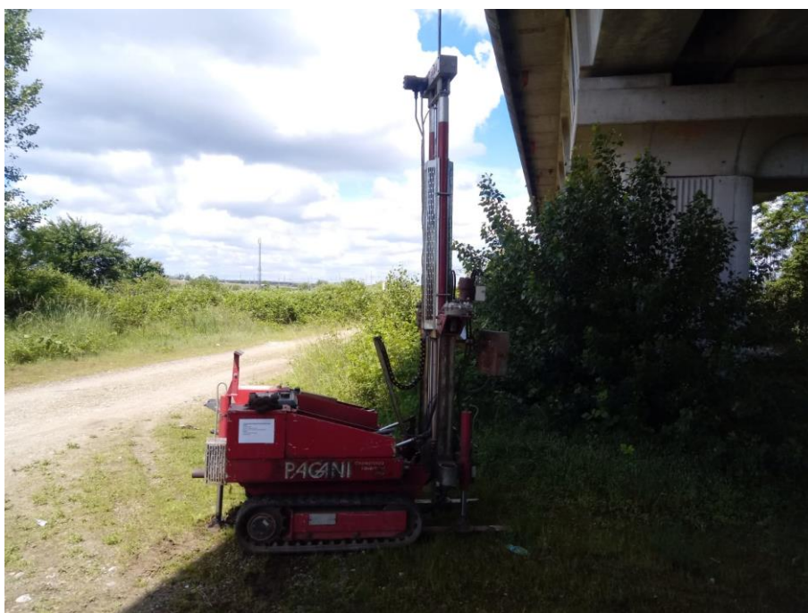
Figura 21 – Penetrometro approntato nella prova DPSH10
