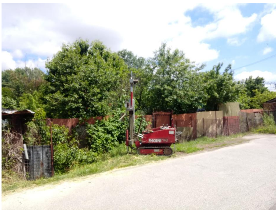
Figura 23 – Penetrometro approntato nella prova DPSH11
