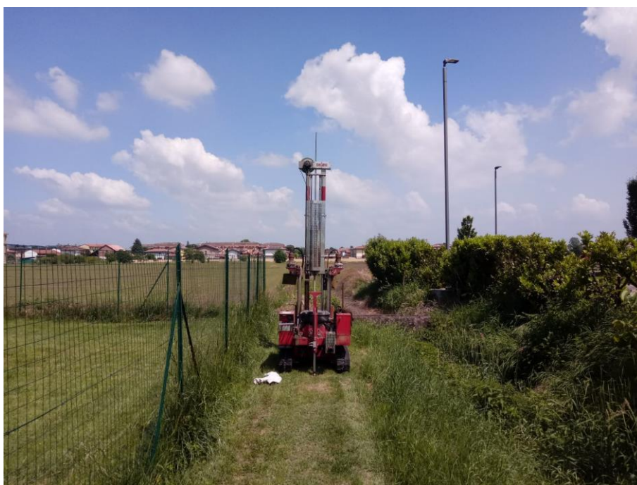
Figura 13 – Penetrometro approntato nella prova DPSH06
