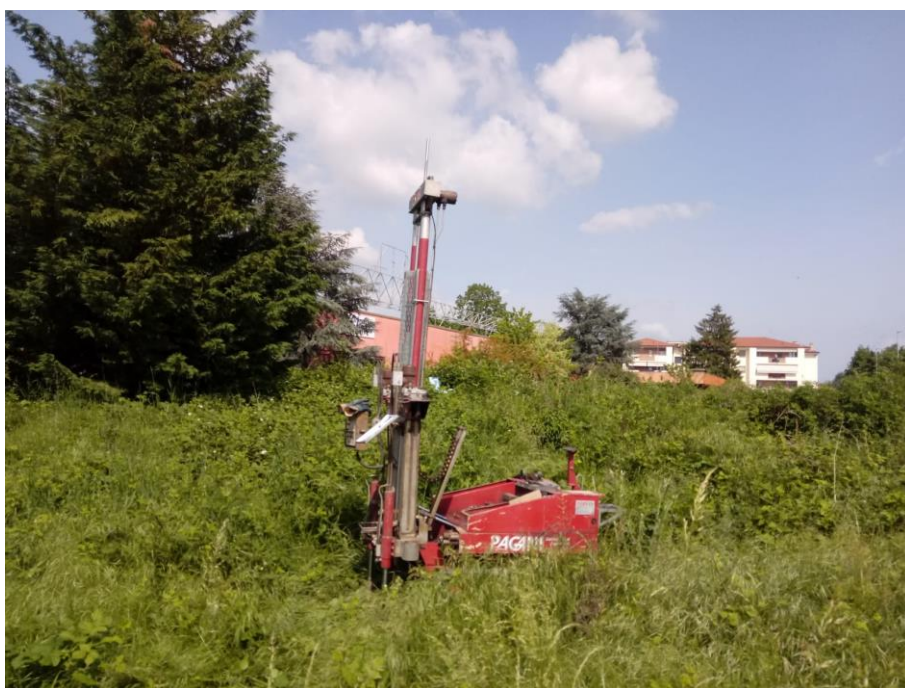
Figura 15 – Penetrometro approntato nella prova DPSH07
