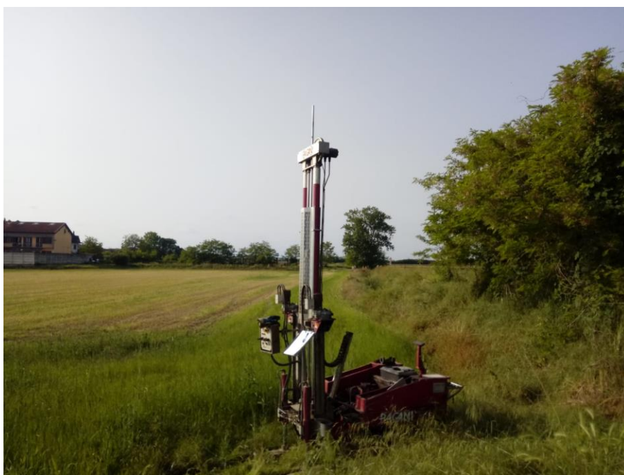
Figura 11 – Penetrometro approntato nella prova DPSH05
