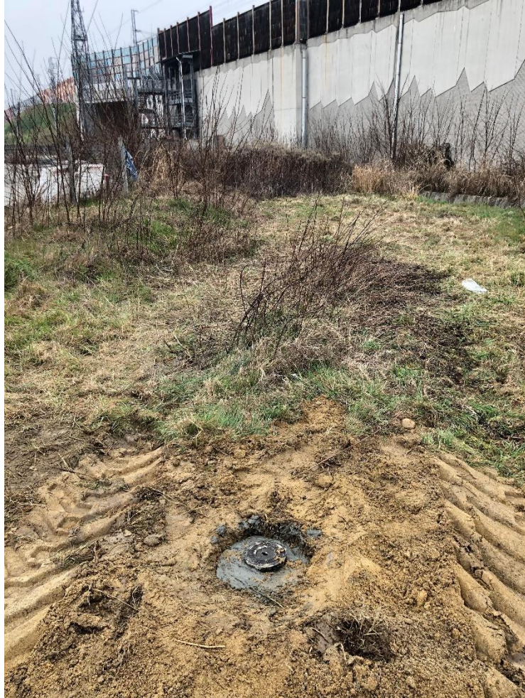
Figura 30 - Pozzetto protezione del tubo piezometrico posto nel sondaggio PDNB01_S3.
