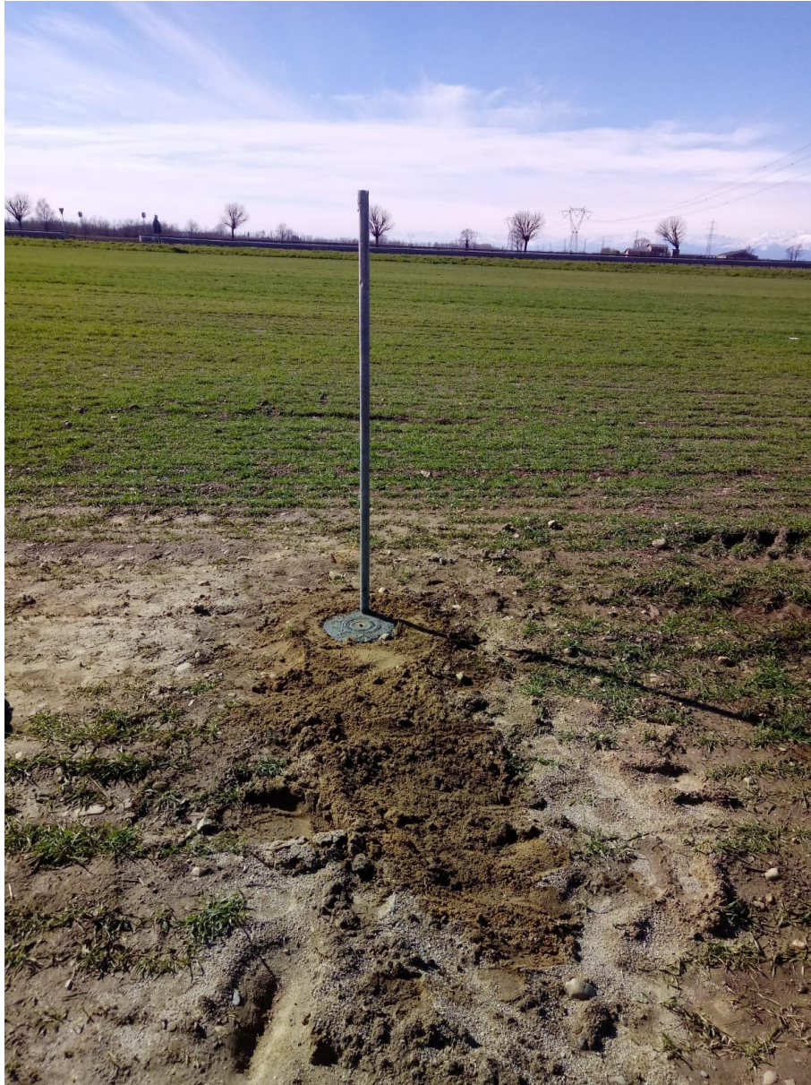
Figura 10 - Pozzetto protezione del tubo piezometrico posto nel sondaggio PDNB01_S1.
