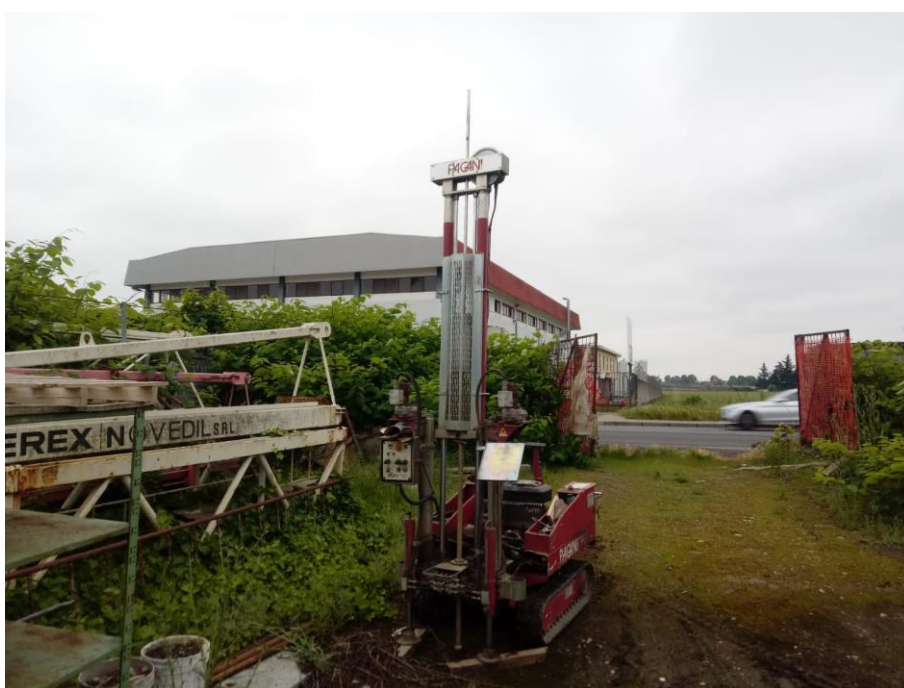
Figura 9 – Penetrometro approntato nella prova DPSH04
