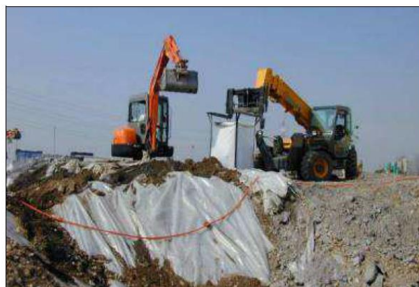
Figura 7-1: Esempio di attività eseguite sotto costante bagnatura ed utilizzo di big bags
