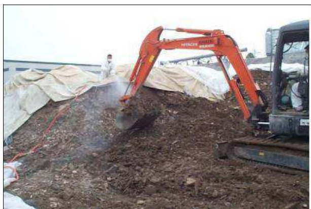
Figura 7-1: Esempio di attività eseguite sotto costante bagnatura ed utilizzo di big bags
