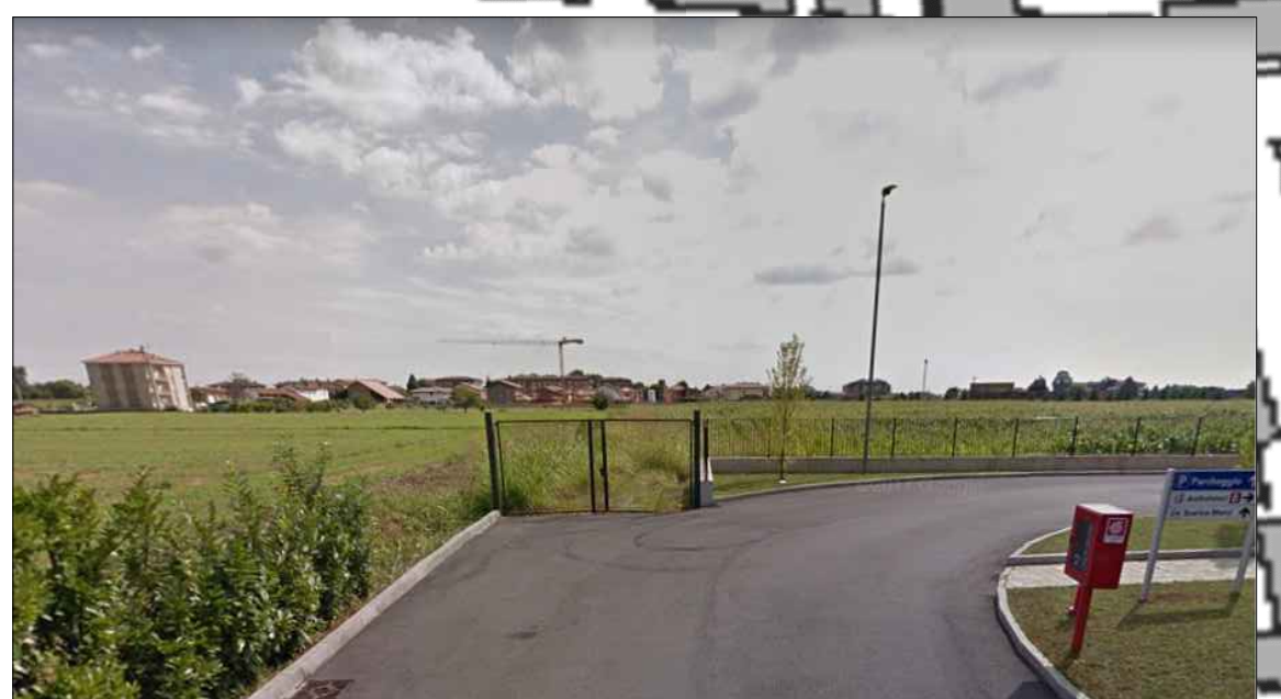
Figura 2 - Accesso area C0.05
