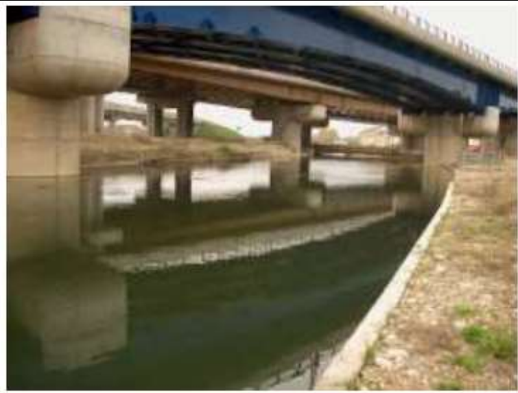
Figura 3.6 – Sovrappasso del Canale Cavour da parte della linea ad Alta Velocità TO-MI
