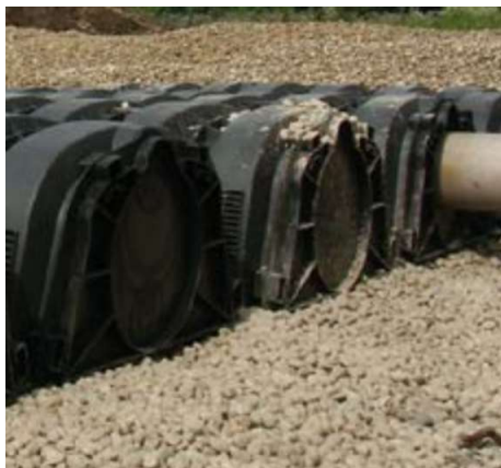
Figura 7.1 – Vasca di prima pioggia e trincee drenanti modulari
