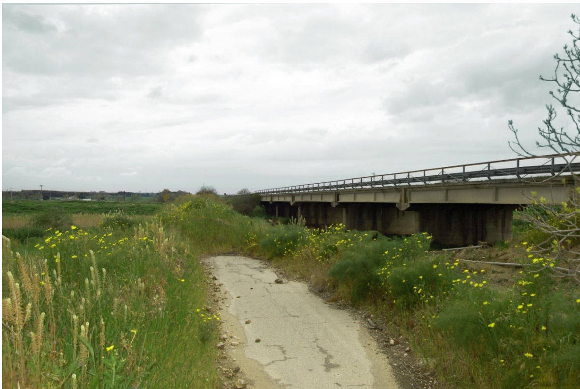
Figura 3-6 Viadotto Candelaro Ante operam
