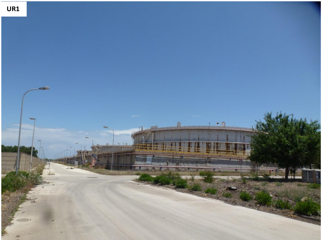
Figura 6 - l'UR1 nella porzione nord della Centrale
