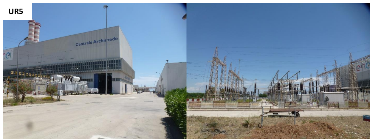
Figura 10 - Area centrale dell'Impianto
