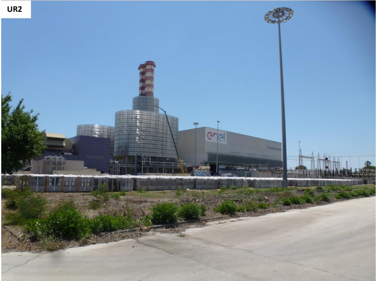
Figura 7 - Area interessata dal Cantiere BESS
