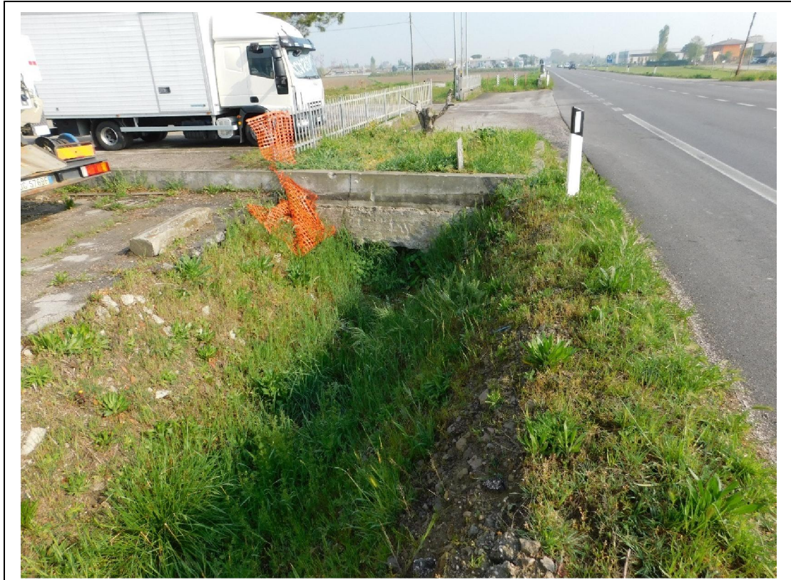
Fig. 5. Incrocio SS 309 – Via del Lavoro – Accesso officina autoriparazioni
