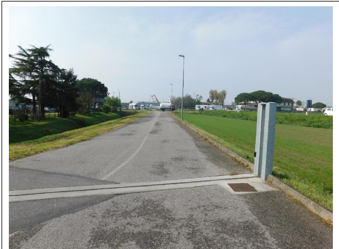
Fig. 6. Incrocio SS 309 – Via del Lavoro – Strada di accesso ad attività commerciali
