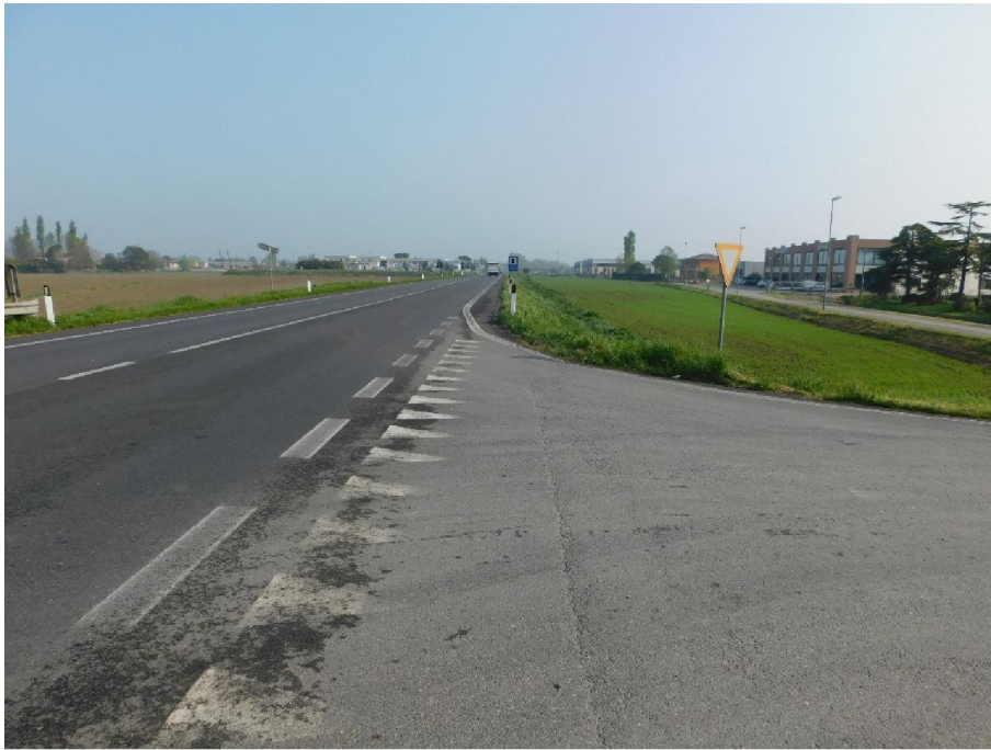
Fig 5. Incrocio fra SS 309 e Via del Lavoro
