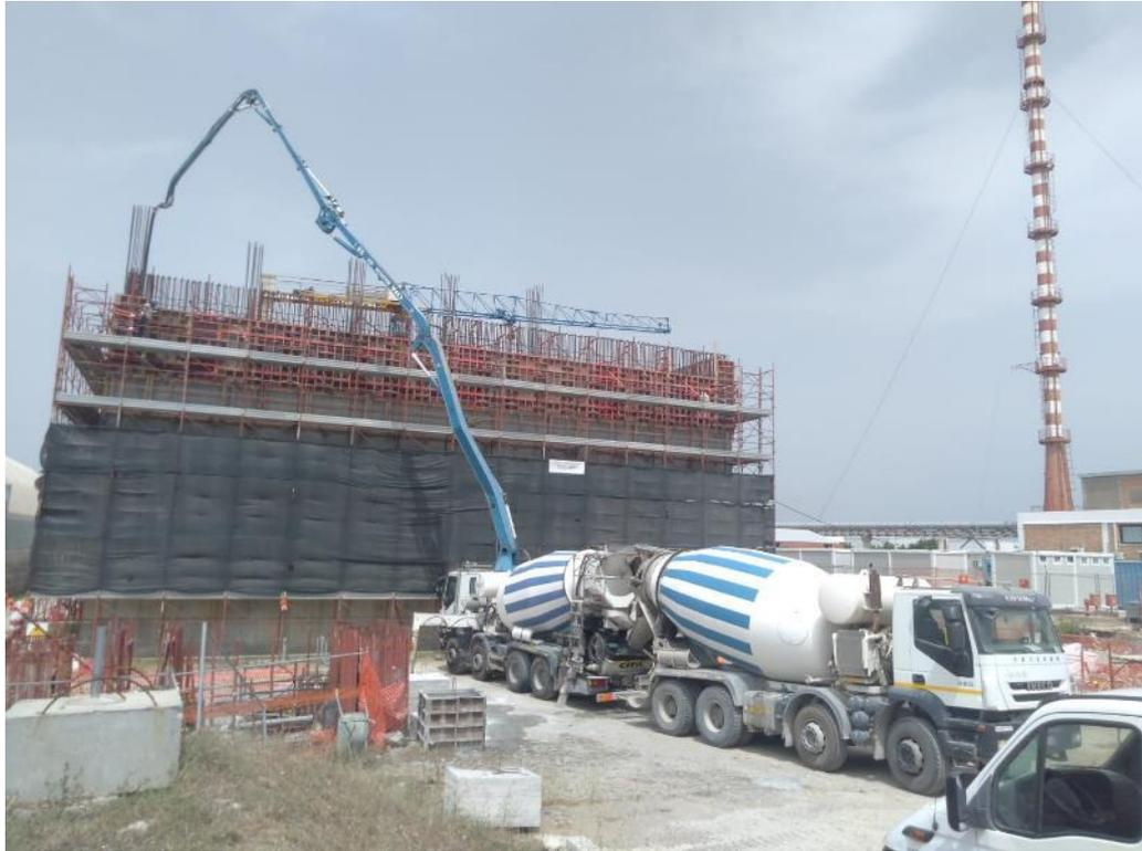
Figura 2.8 Foto di cantiere particolare getto strutture in elevazione
