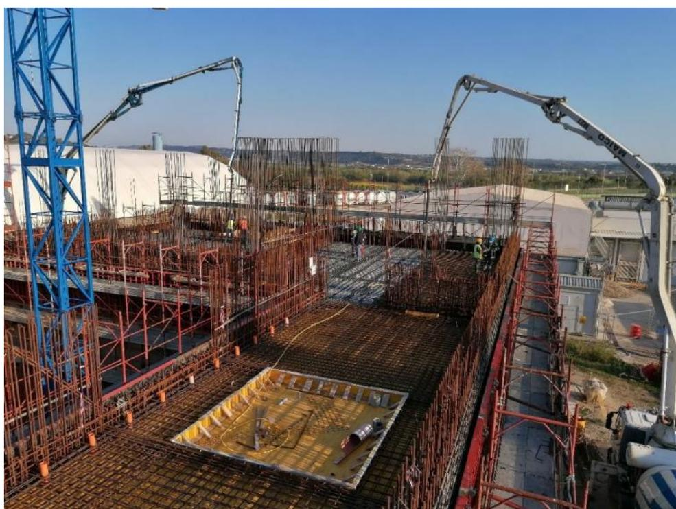
Figura 2.5 Foto di cantiere particolare getto solaio a quota + 5,95
