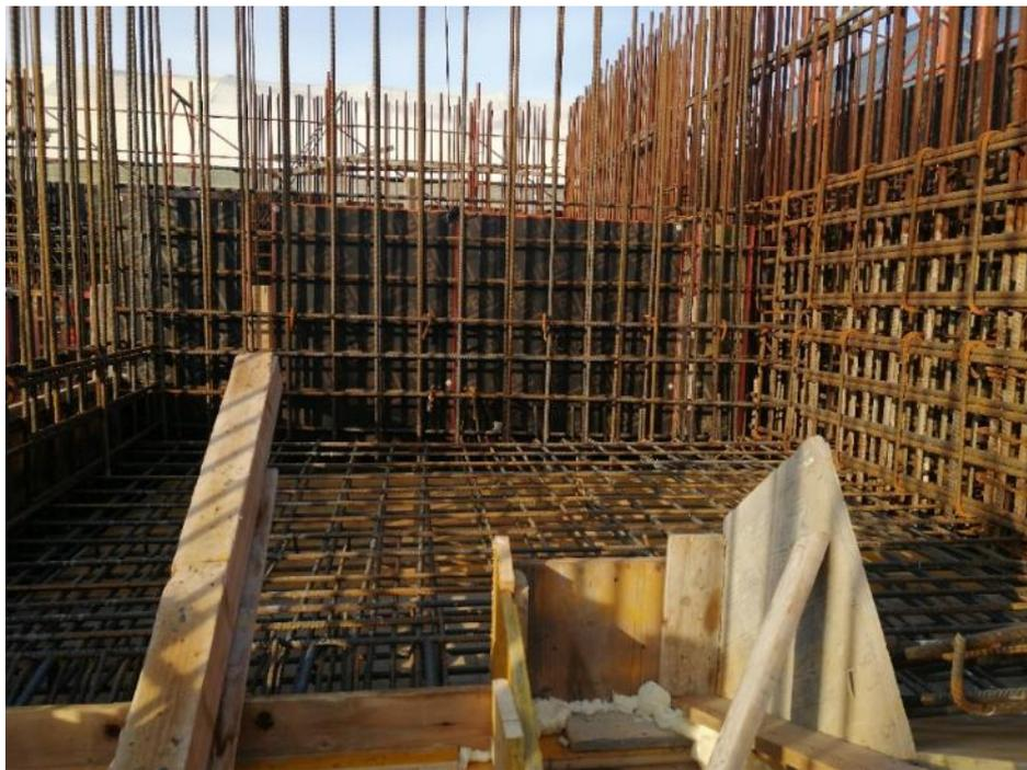
Figura 2.3 Foto di cantiere particolare armatura e casseri delle strutture in elevazione
