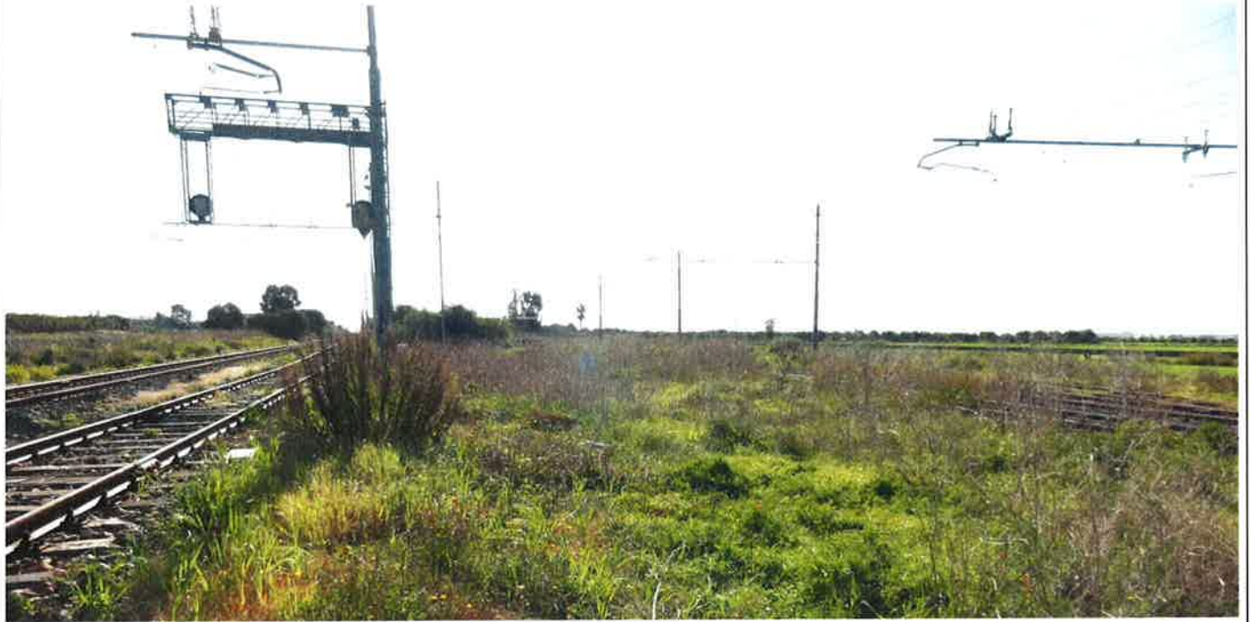
Vista dell'area destinata al cantiere di armamento, nell'ambito dello scalo ferroviario di Sferro.
