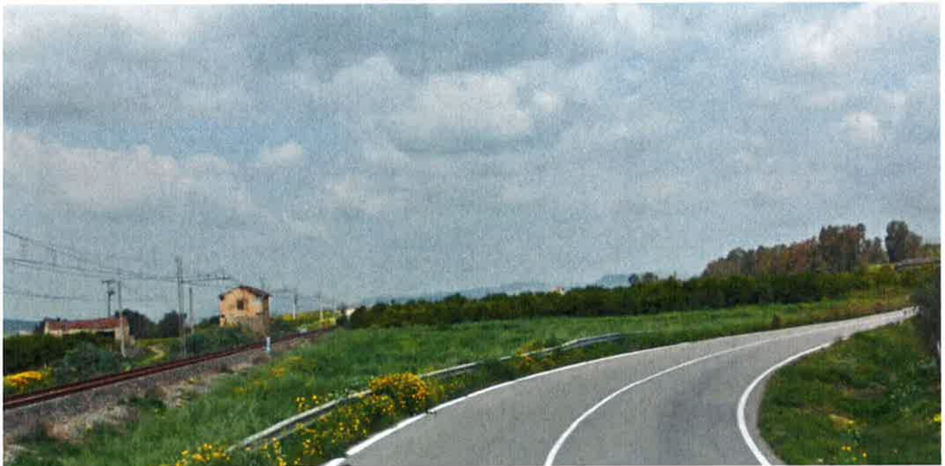
Vista dell'area destinata al cantiere dalla SS192.
