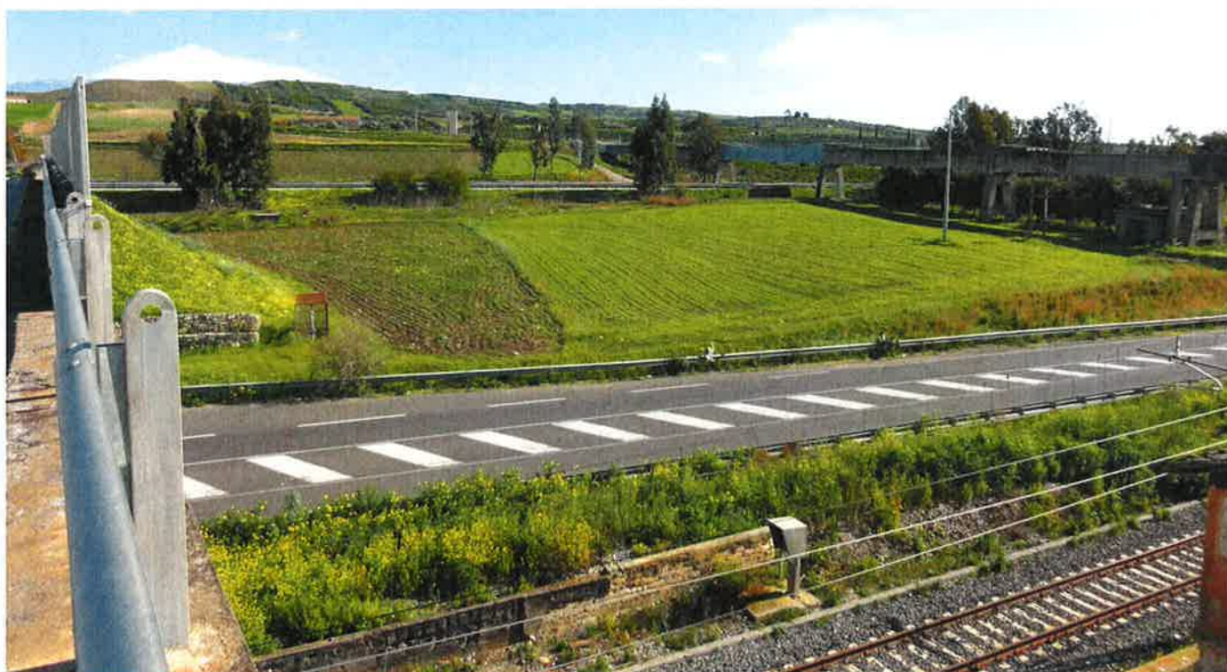
Vista dell'area destinata al cantiere dal cavalcavia di raccordo alla SS192.
