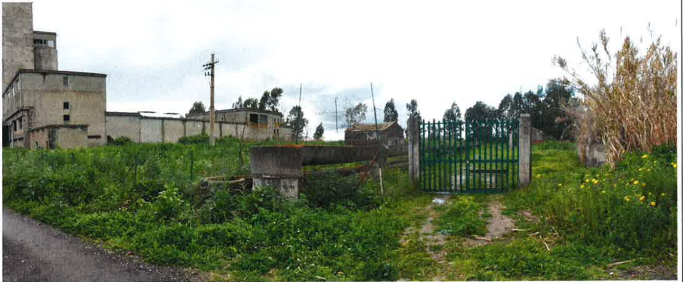
Vista dell'area destinata al cantiere per la realizzazione del cavalcaferrovia IV04.
