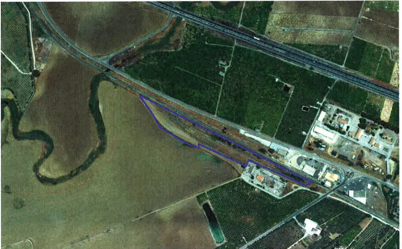
Vista aerea dell'area destinata al cantiere di armamento (Ortofoto da Google Earth, 2010).
