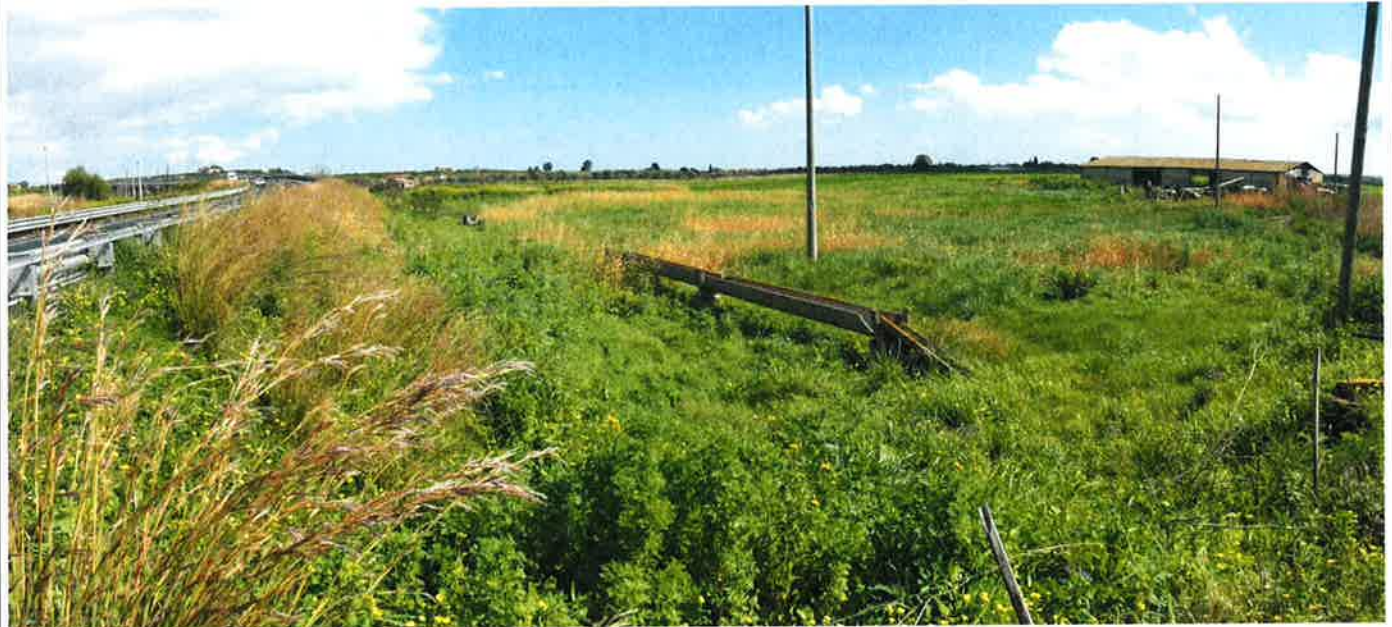
Vista dell'area destinata al cantiere; sulla sinistra la SS417.
