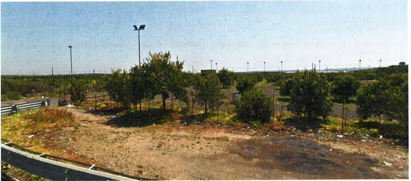
Vista dell'area destinata al cantiere per la realizzazione del cavalcaferrovia IV05.
