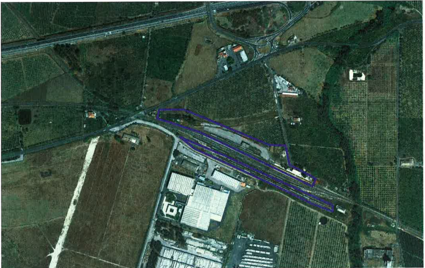
Vista aerea dell'area destinata al cantiere di armamento (Ortofoto da Google Earth, 2010).
