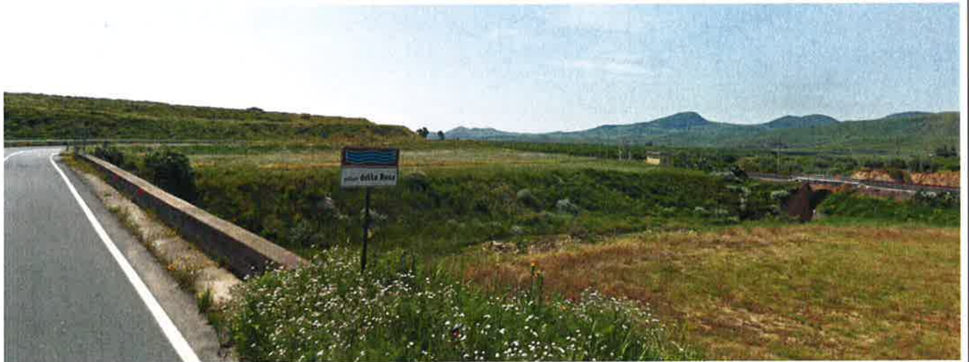
Vista dell'area destinata al cantiere per la realizzazione del viadotto Vallone della Rosa.
