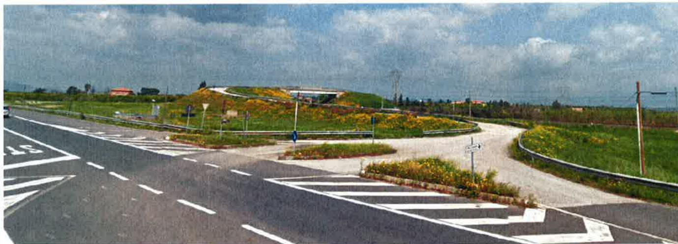
Vista dell'area destinata al cantiere in corrispondenza dello svincolo di raccordo con la SS192.
