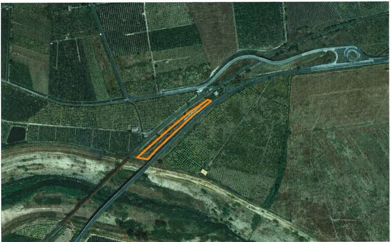
Vista aerea dell'area (ortofoto da Google Earth, aggiornamento 2010).
