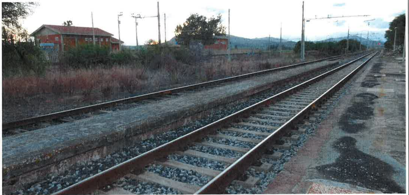
Vista dalla stazione di Sferro dello scalo ferroviario in stato di abbandono.
