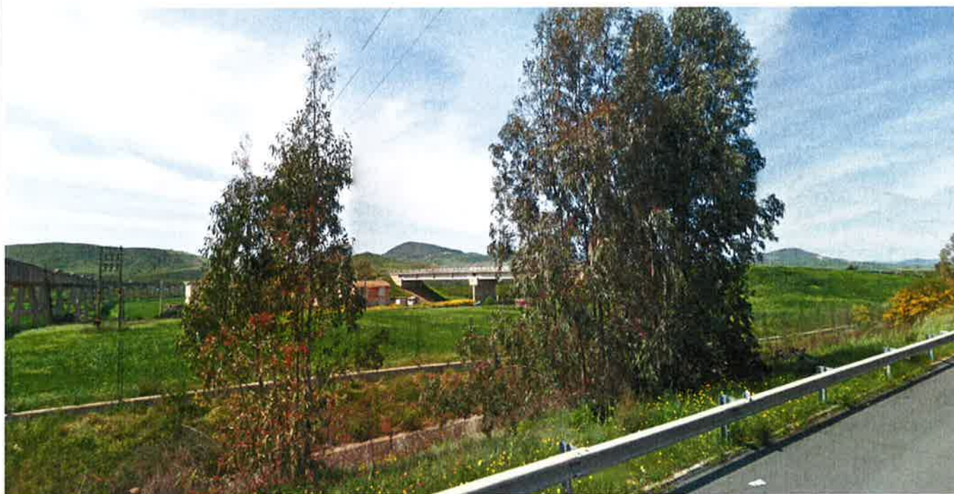
Vista dell'area destinata al cantiere dall'autostrada A19.
