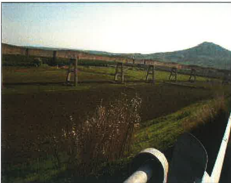
Fig. 1: Acquedotto del Consorzio di Bonifica della Piana di Catania (1961)
