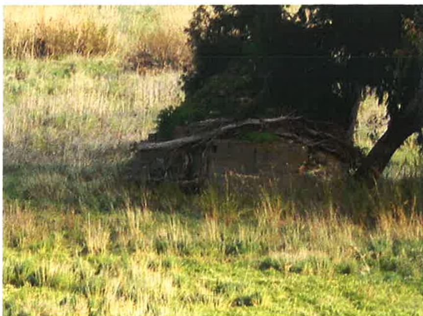
Fig. 2: I resti del ponte romano di Giarretta dei Monaci
