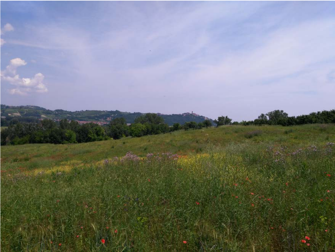
Figura 22 - Vista panoramica del versante in frana.
