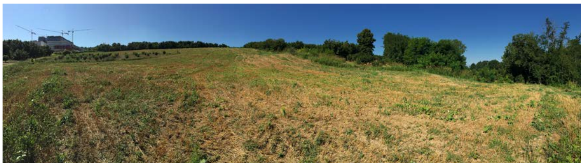
Figura 5 - Zona di frana, si può vedere a sinistra l'ospedale durante i lavori di ampliamento.
