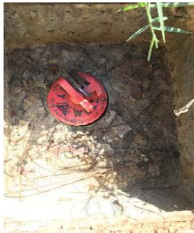
Dettaglio testa piezometro.
