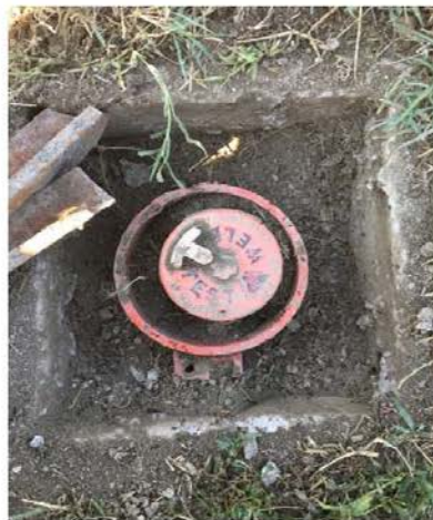
Dettaglio testa piezometro.
