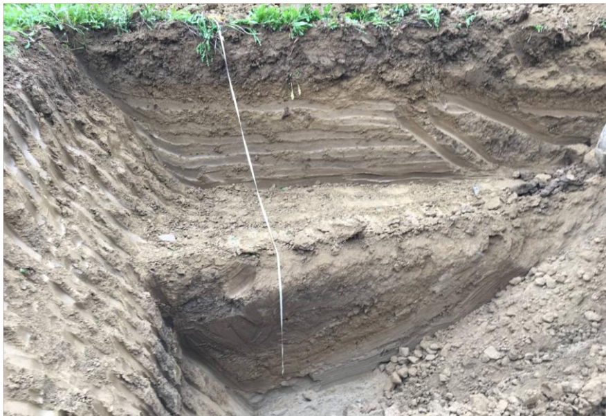
SCAVI DI POZZETTO ESPLORATIVO A 3,00 m
