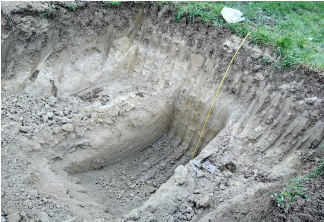
SCAVI DI POZZETTO ESPLORATIVO A 3,00 m
