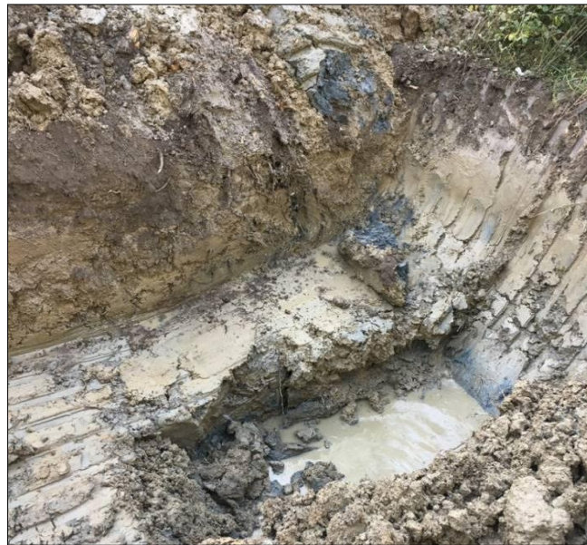
SCAVI DI POZZETTO ESPLORATIVO A 2,00 m
