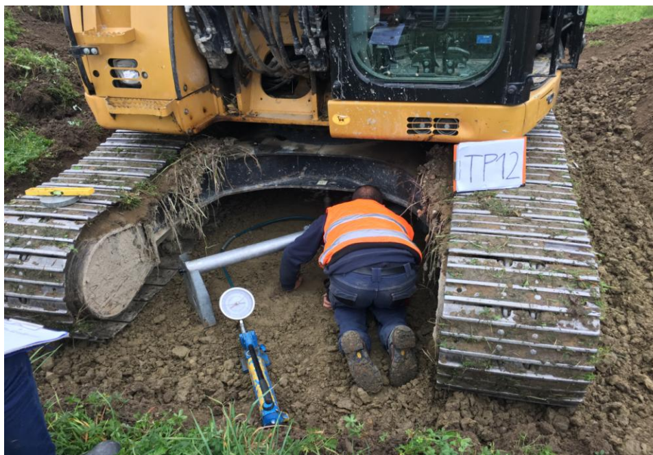
POSTAZIONE ESCAVATORE MECCANICO SU POZZETTO TP 12
