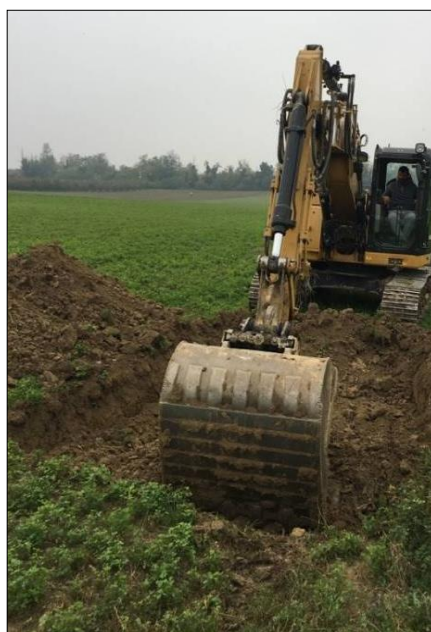
POSTAZIONE ESCAVATORE MECCANICO SU POZZETTO TP 13
