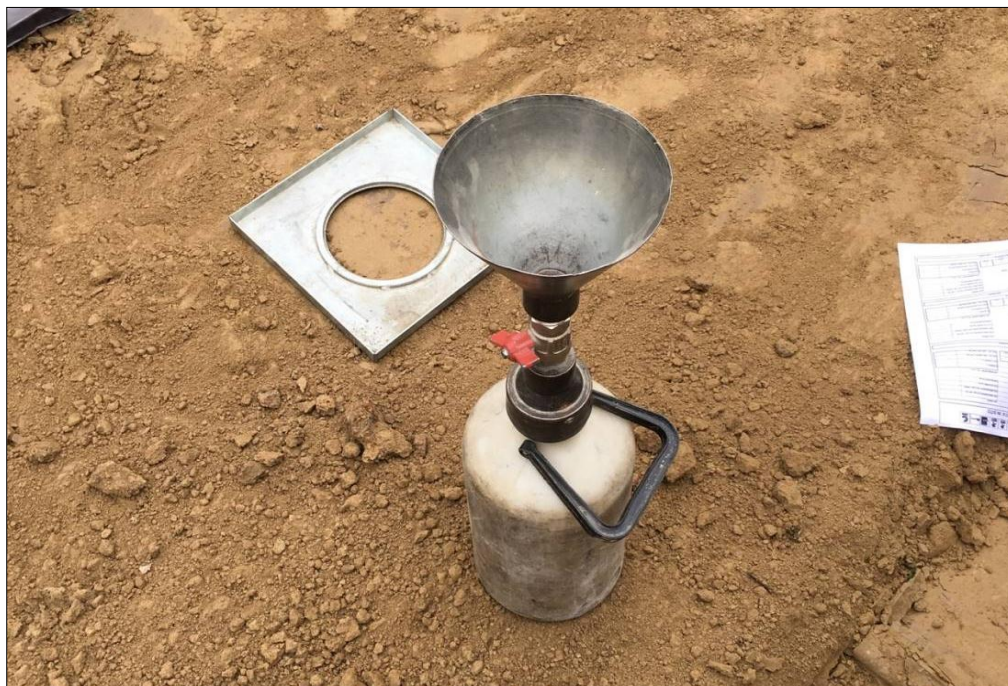
PROVA DI DENSITA' IN SITU
