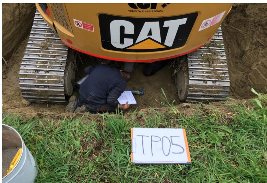
POSTAZIONE ESCAVATORE MECCANICO SU POZZETTO TP 05
