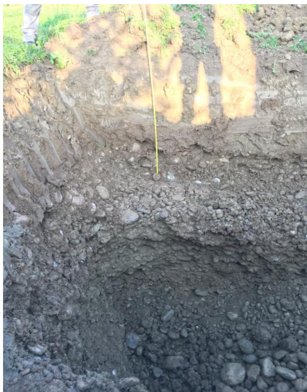
SCAVI DI POZZETTO ESPLORATIVO A 3,00 m
