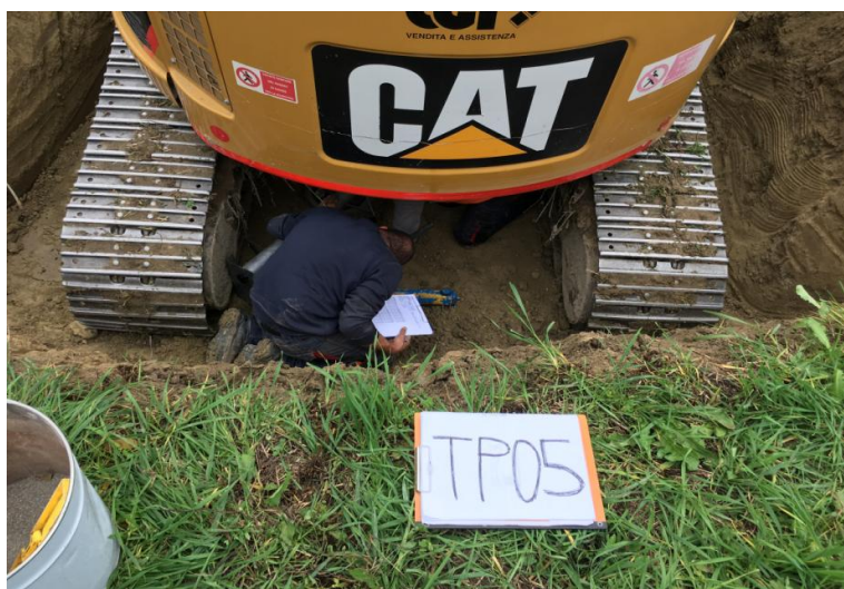
ESECUZIONE DI PROVA DI CARICO SU PIASTRA
