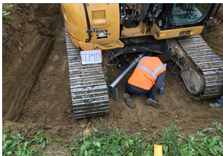
ESECUZIONE DI PROVA DI CARICO SU PIASTRA
