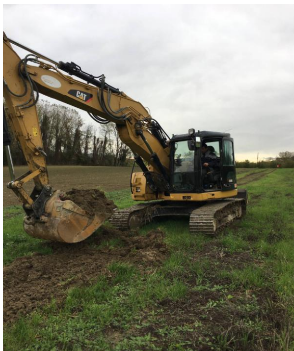
POSTAZIONE ESCAVATORE MECCANICO SU POZZETTO TP 07
