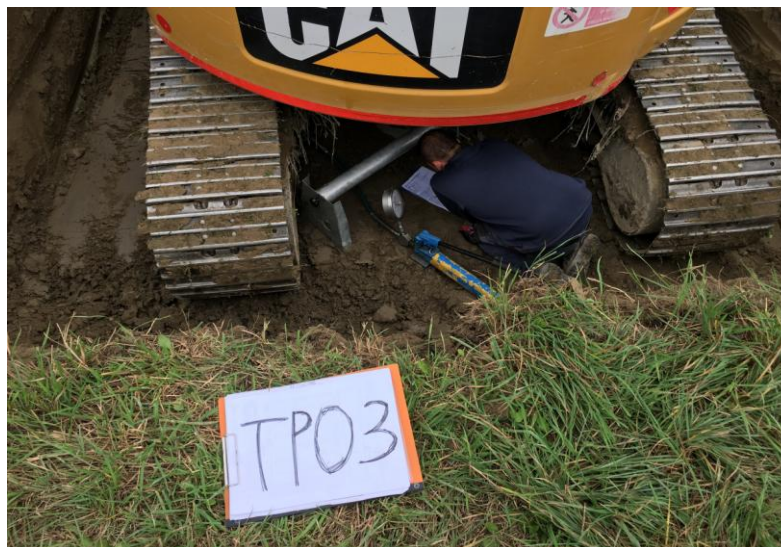
ESECUZIONE DI PROVA DI CARICO SU PIASTRA
