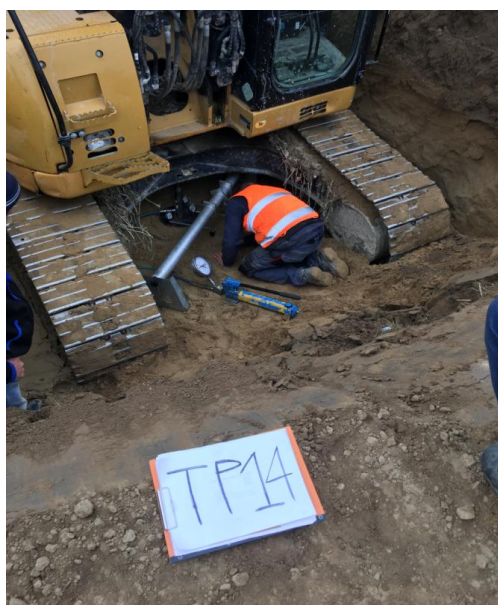
ESECUZIONE DI PROVA DI CARICO SU PIASTRA
