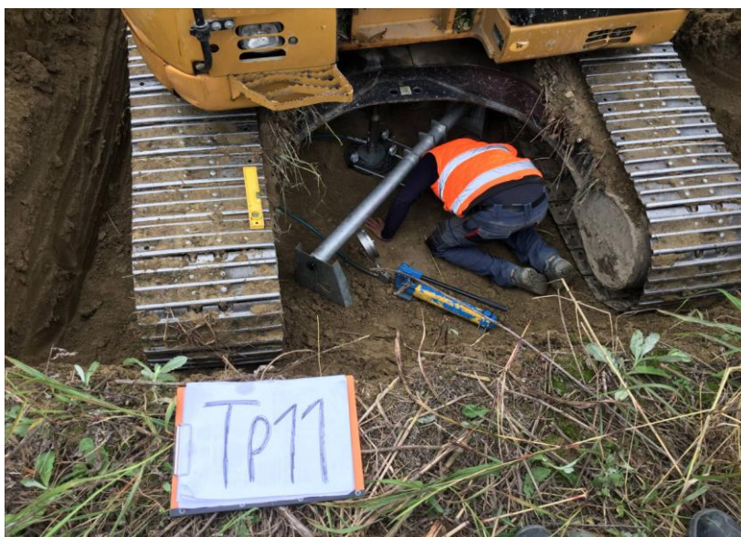
ESECUZIONE DI PROVA DI CARICO SU PIASTRA
