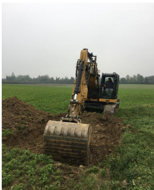
POSTAZIONE ESCAVATORE MECCANICO SU POZZETTO TP 04
