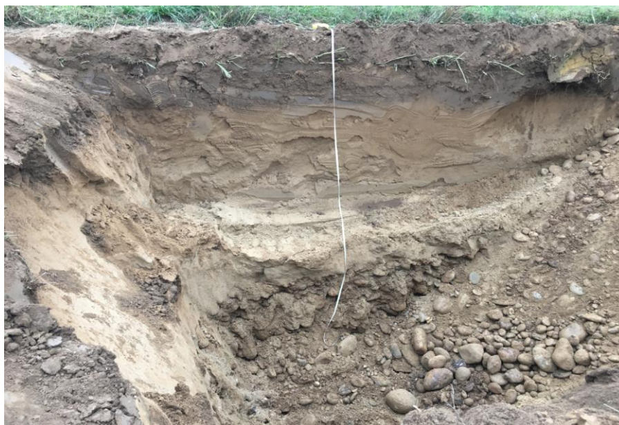
SCAVI DI POZZETTO ESPLORATIVO A 3,00 m
