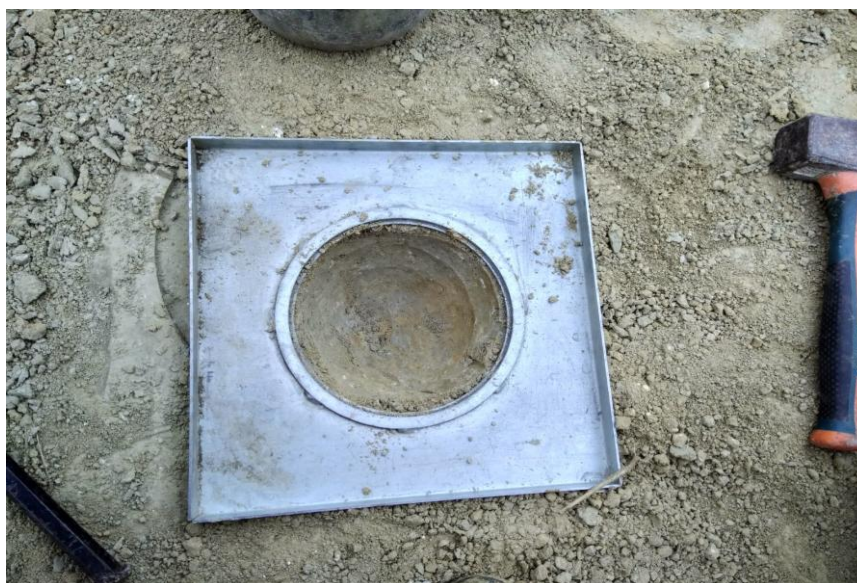
PROVA DI DENSITA' IN SITU
