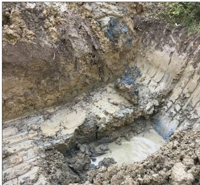
SCAVI DI POZZETTO ESPLORATIVO A 2,00 m
