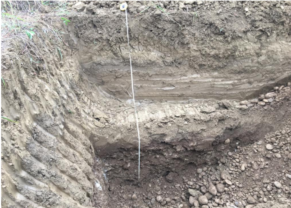
SCAVO DI POZZETTO ESPLORATIVO A 3,00 m
