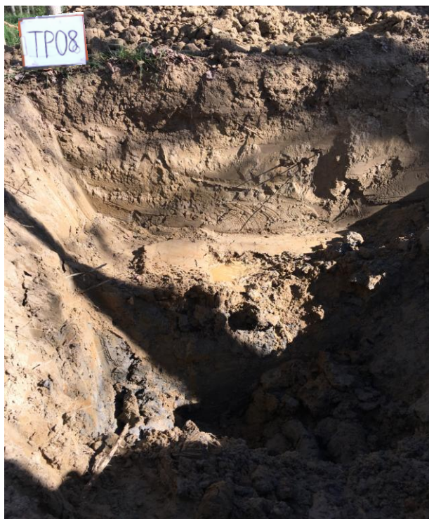
SCAVI DI POZZETTO ESPLORATIVO A 3,00 m
