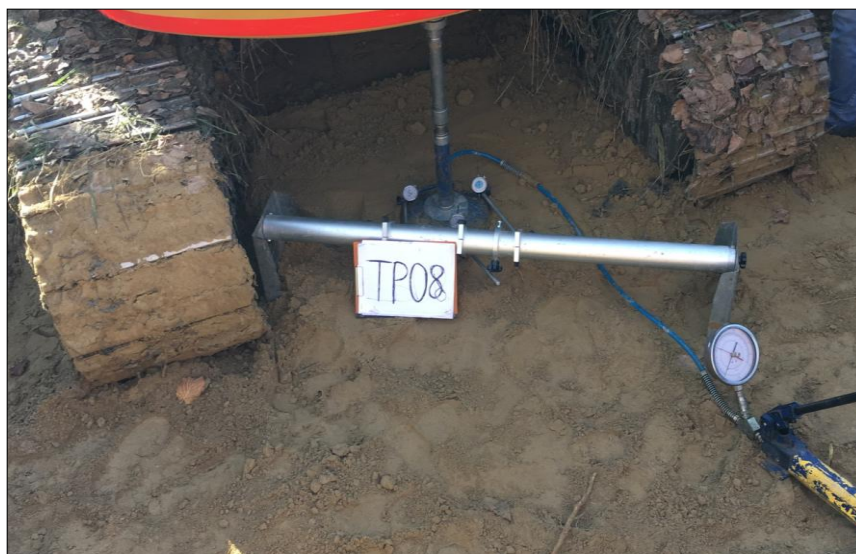
ESECUZIONE DI PROVA DI CARICO SU PIASTRA
