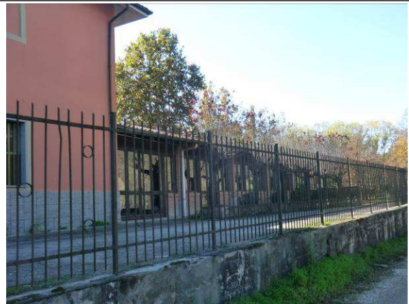
Vista Nord / Est
