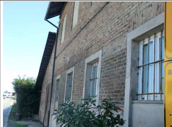
Vista Sud / Ovest
