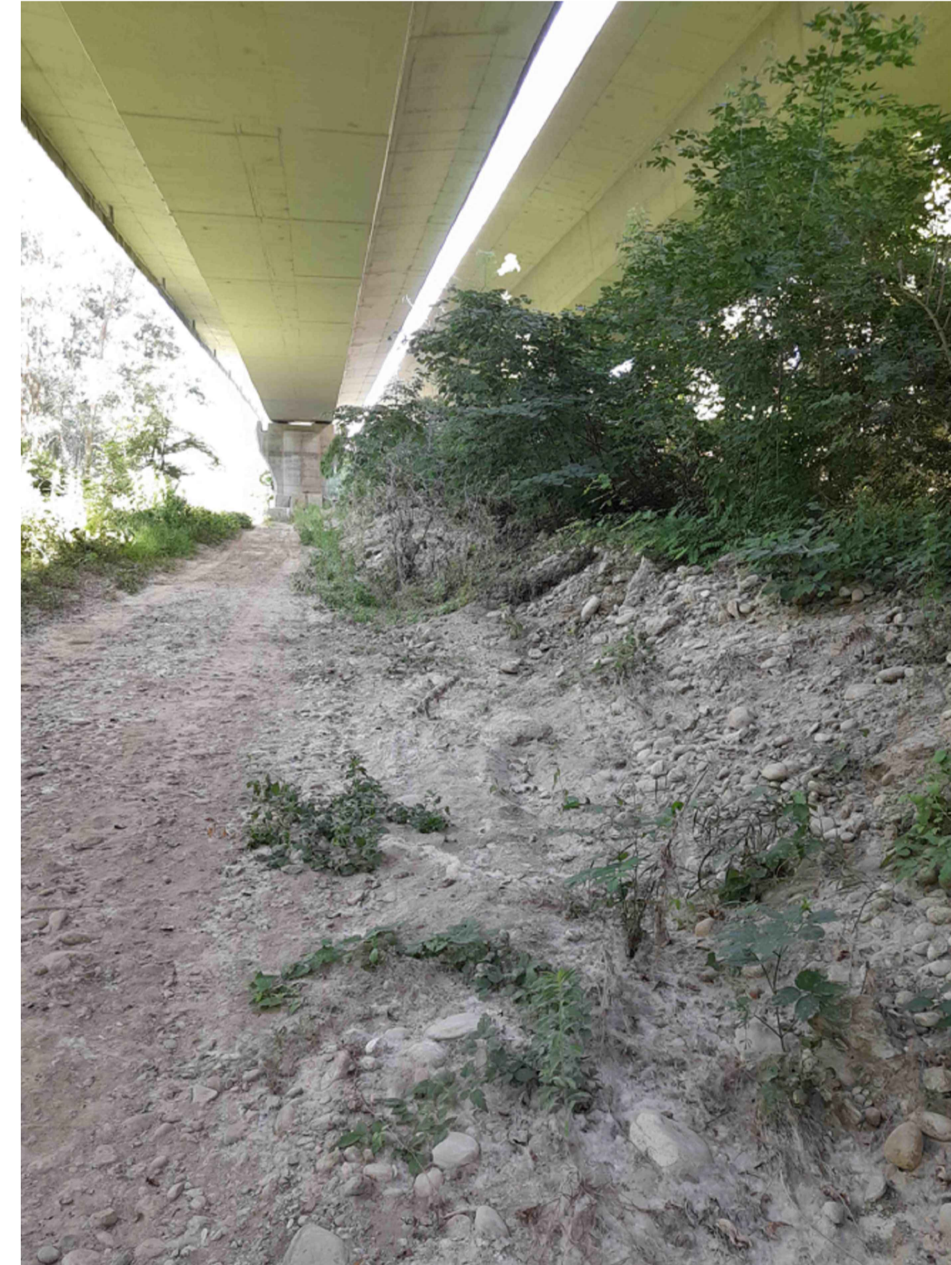
Rimozione materiale per un quantitativo di circa 555mc x 15m = 833mc
