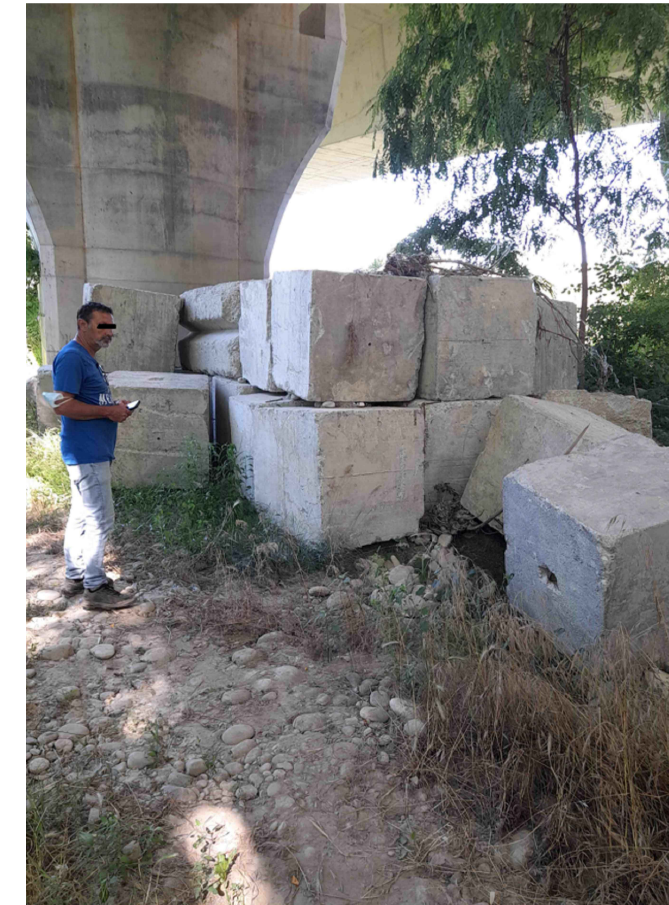
Rimozione blocchi per un quantitativo di circa 20mc
