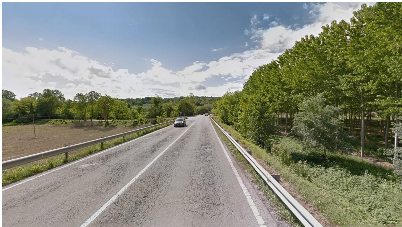
Figura 5-2 Punto di vista F.1: Stato ante operam
