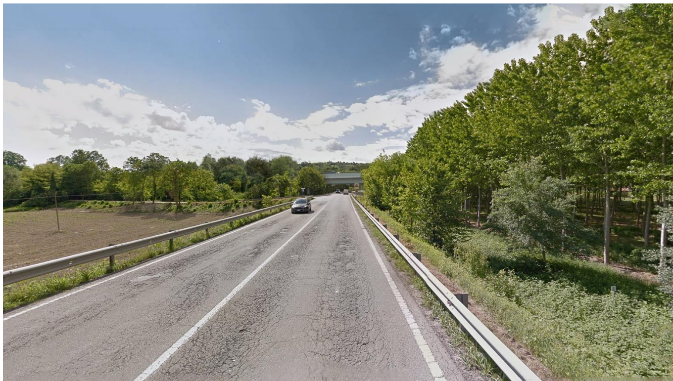
Figura 5-3 Punto di vista F.1: Stato post mitigazione
