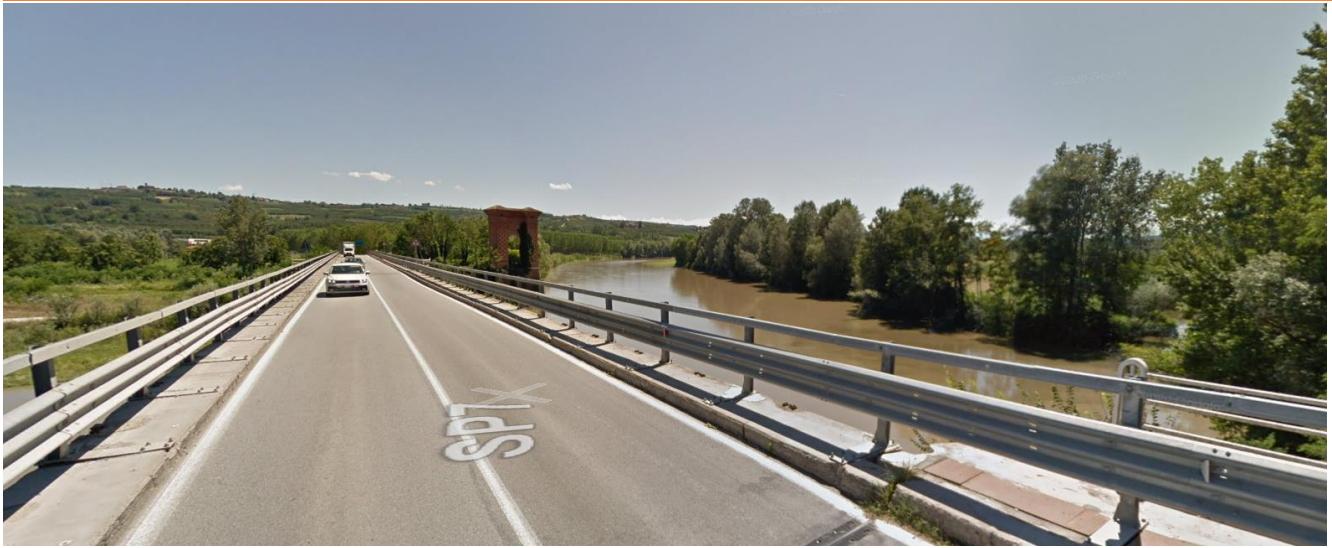
Figura 3-6 Punto di vista A1.5 (Fonte: Streetview)
