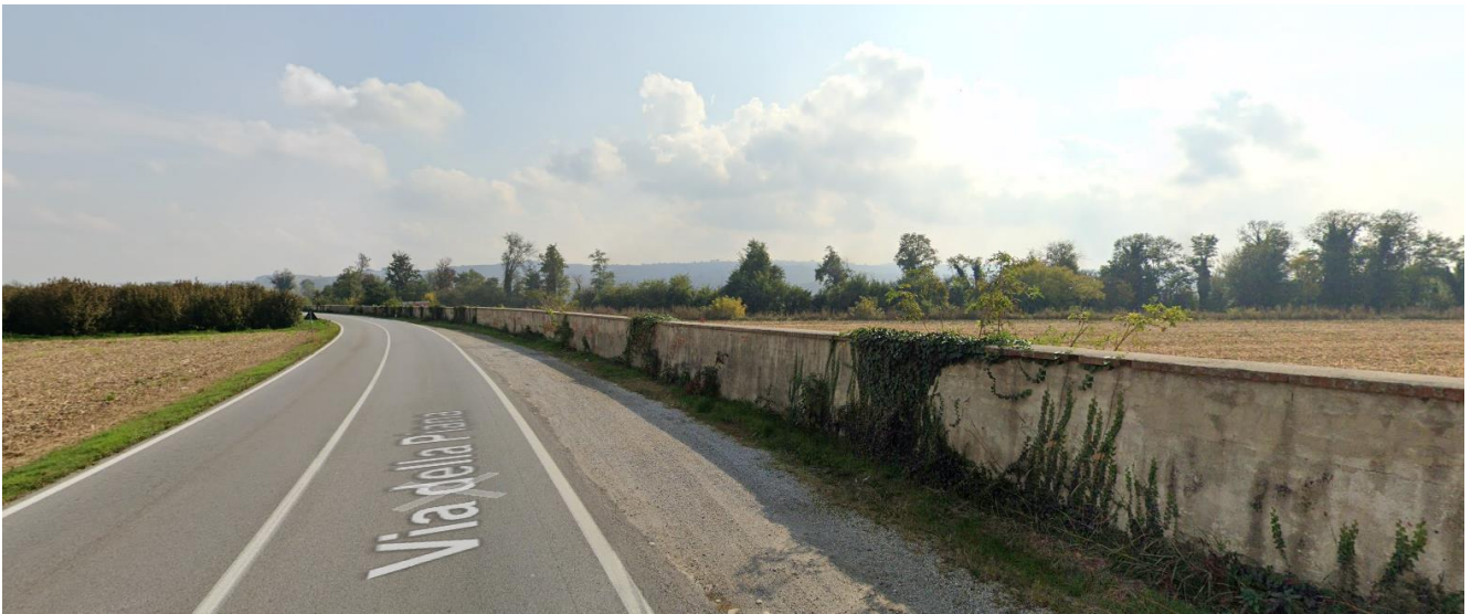
Figura 3-4 Punto di vista A1.3 (Fonte: Streetview)
