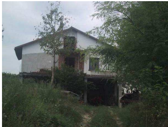
Vista da Nord
