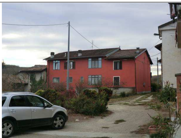
Vista da Nord
