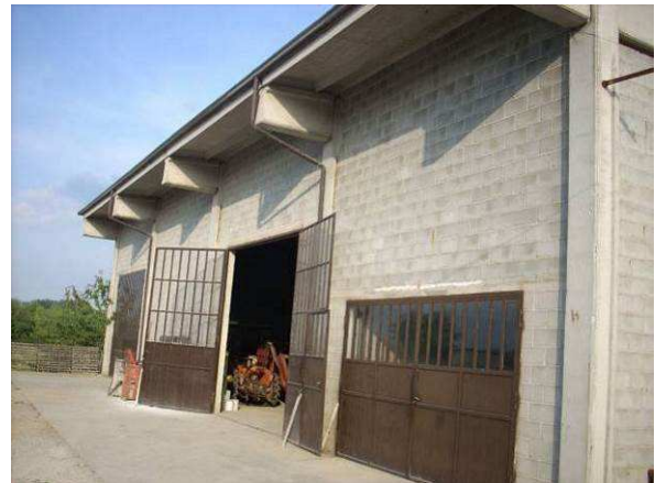
Vista da Nord
