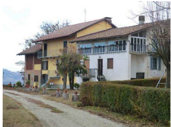
Vista da Ovest
