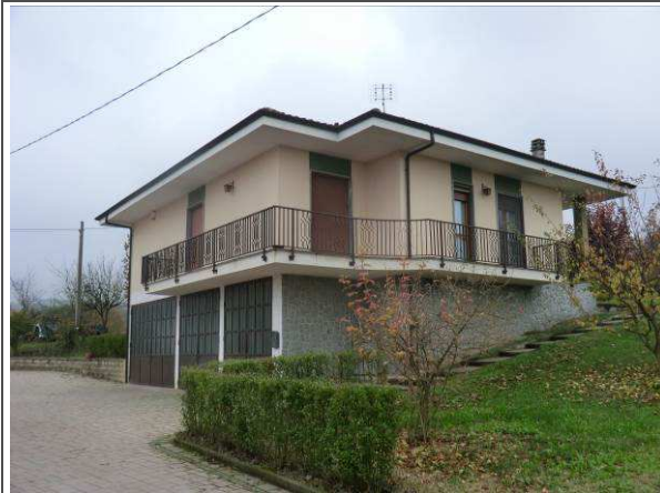
Vista da Nord
