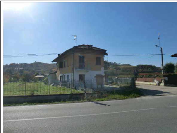
Vista da Nord
