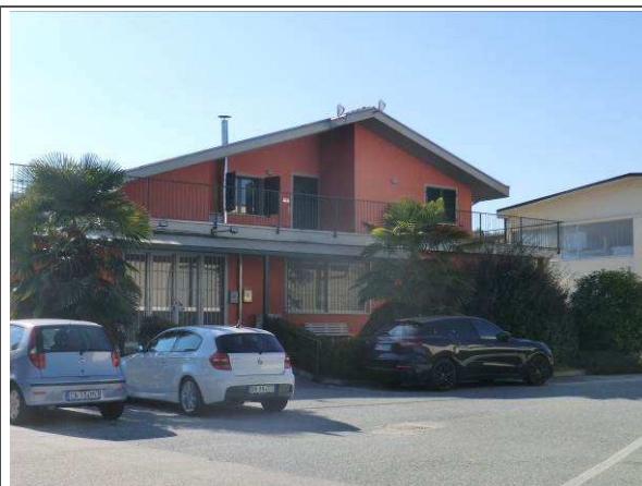
Vista da Nord
