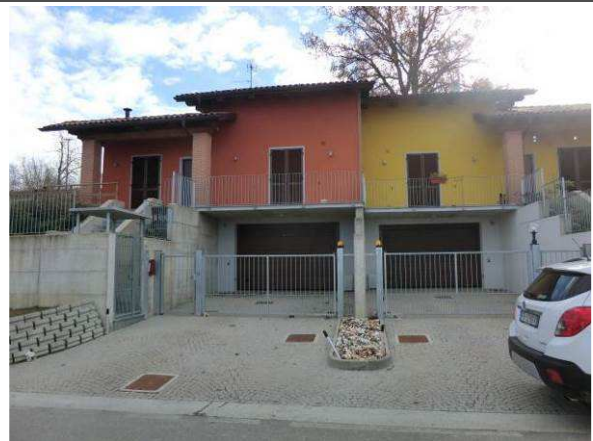
Vista da Nord
