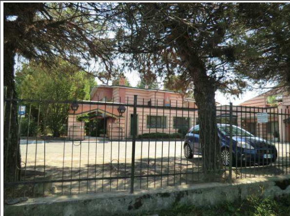
Vista da Nord
