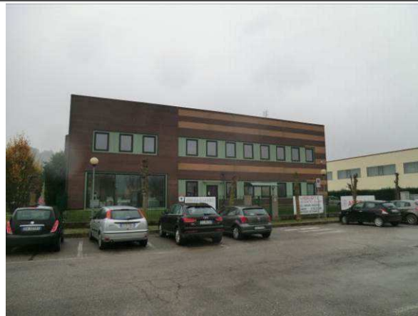
Vista da Nord
