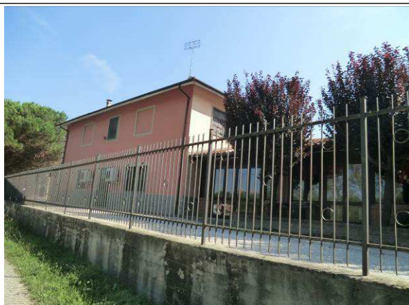
Vista da Nord
