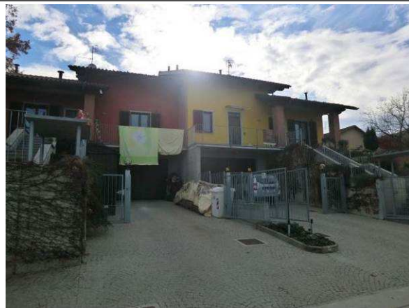
Vista da Nord
