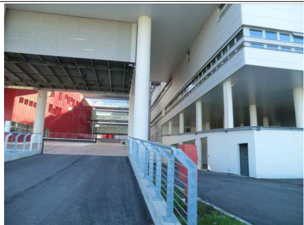
Vista da Nord
