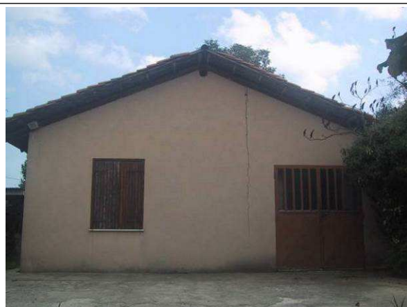
Vista da Ovest
