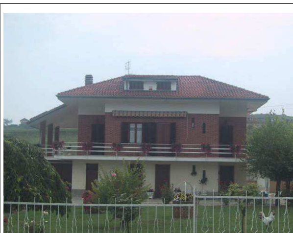
Vista da Ovest
