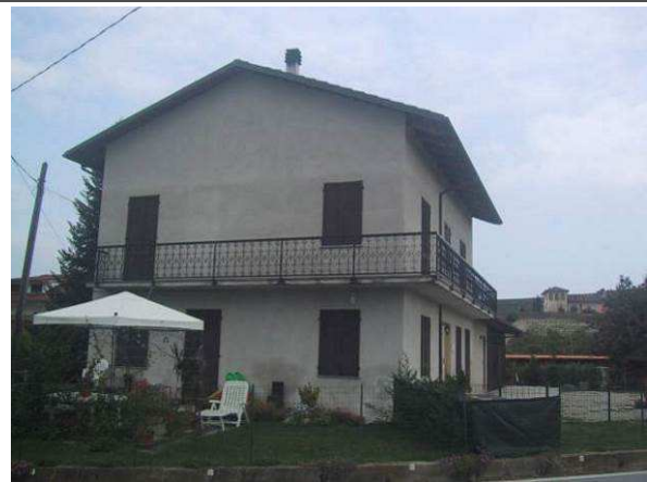
Vista da Ovest
