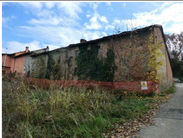
Vista da Nord
