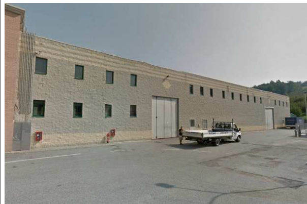
Vista da Ovest
