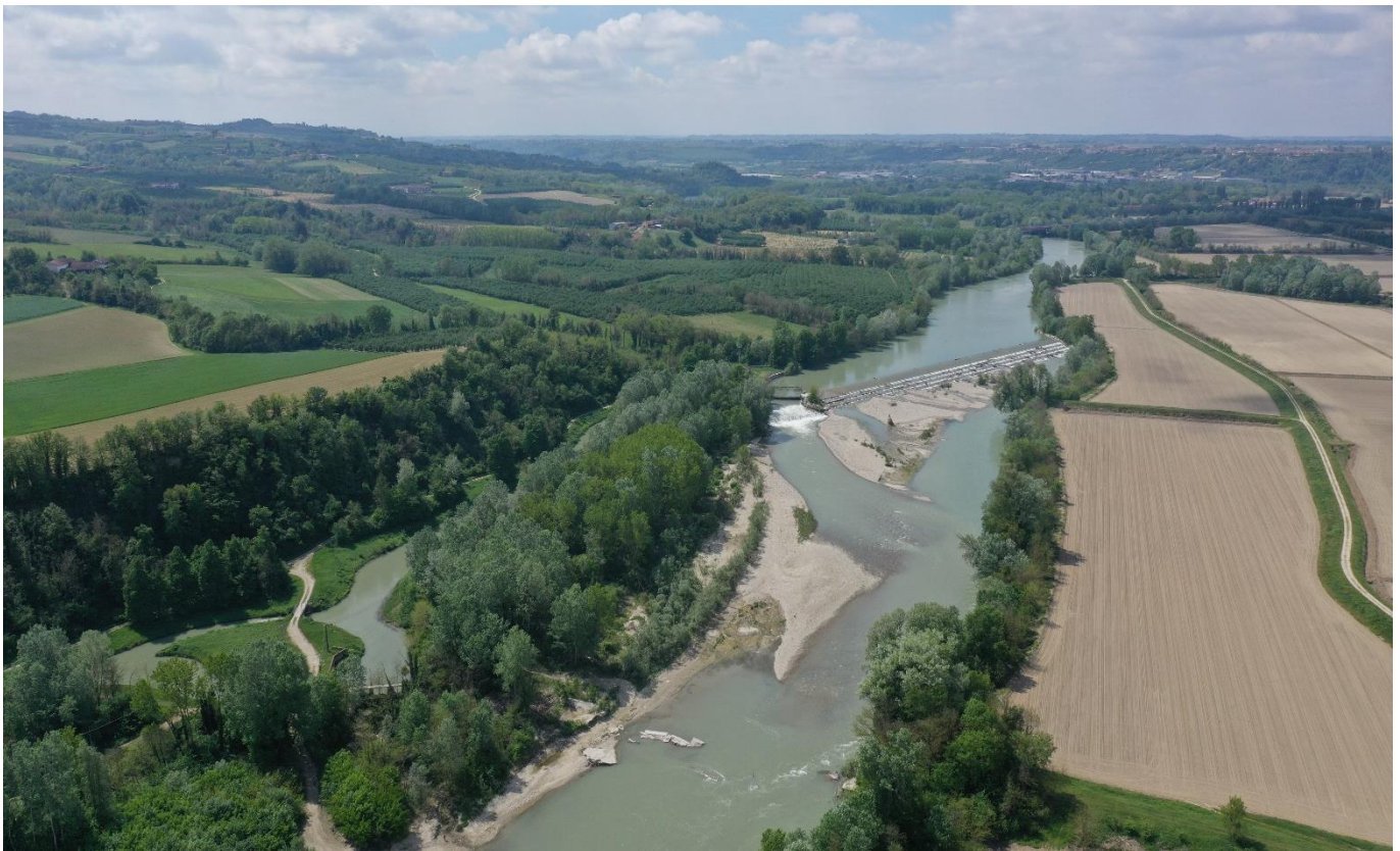
Figura 2-7 La dimensione variabile dell'alveo del Fiume Tanaro (Fonte: IRIDE srl, rilievo con APR)
