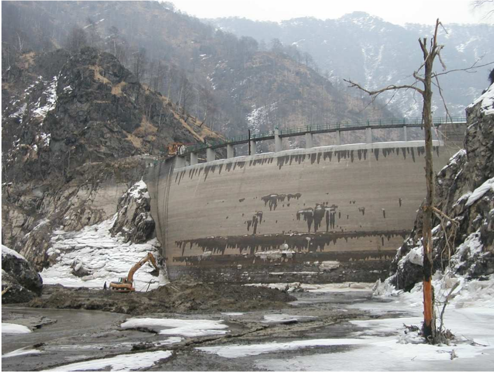
Figura 1 – Diga delle Miste. Vista della zona antistante il paramento di monte.
