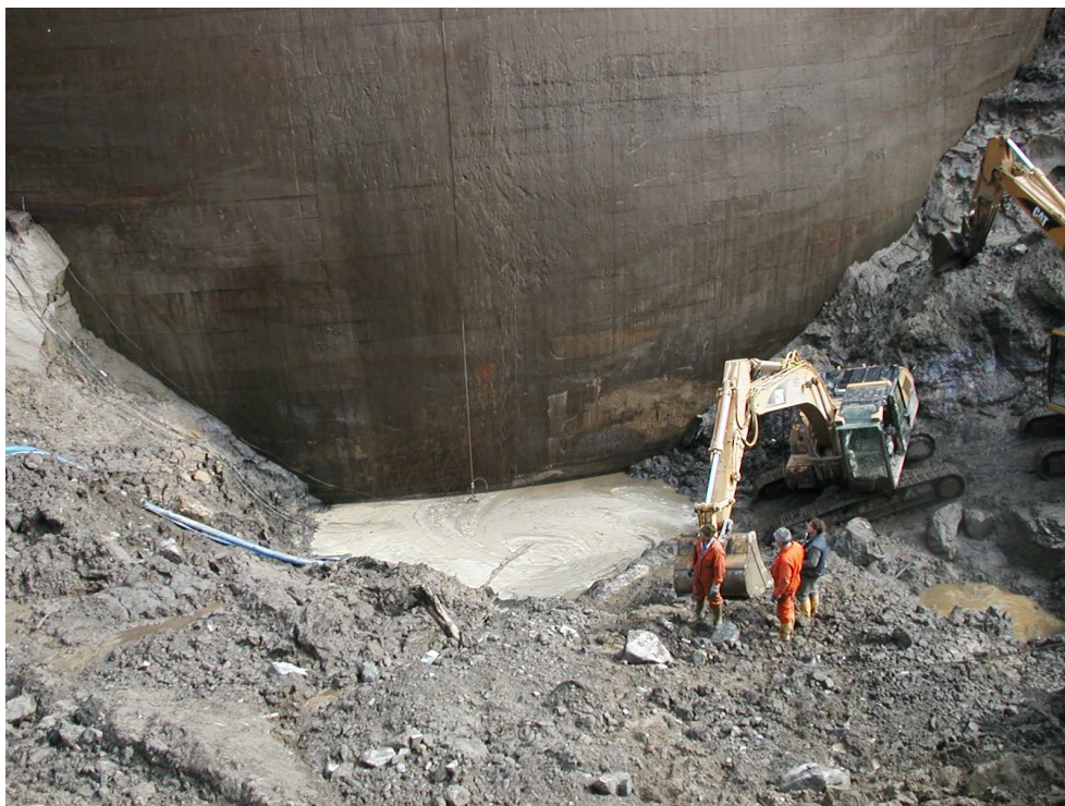
Figura 6 - Diga delle Miste. Particolare della zona della scarico di fondo.
