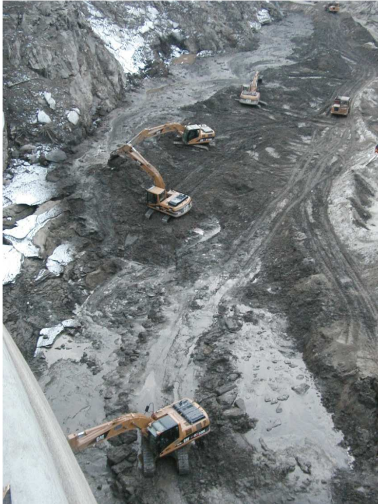
Figura 4 - Diga delle Miste. Particolare della zona nelle adiacenze dello scarico di fondo.
