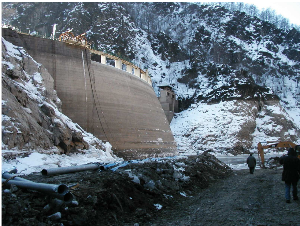
Figura 3 - Diga delle Miste. Particolare della zona antistante il paramento di monte in sponda sinistra.
