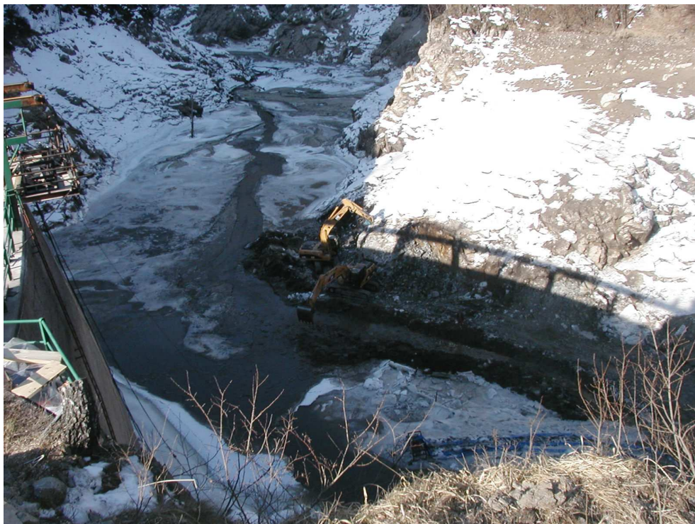
Figura 5 - Diga delle Miste. Vista dello sperone in sponda sinistra.
