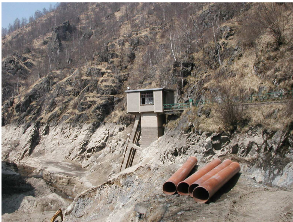
Figura 8 – Torre di presa.
