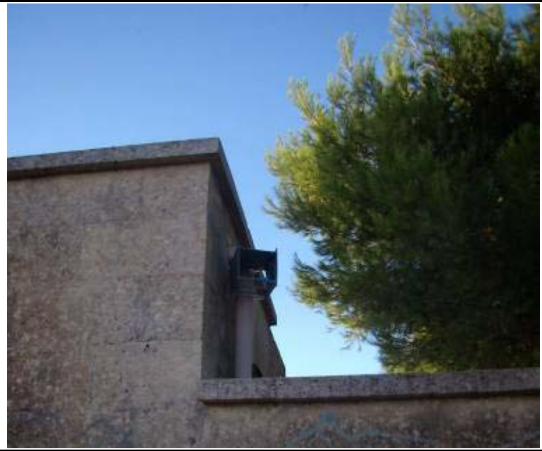
Figura 6-75 Campionatore passivo posizionato su un pluviale
