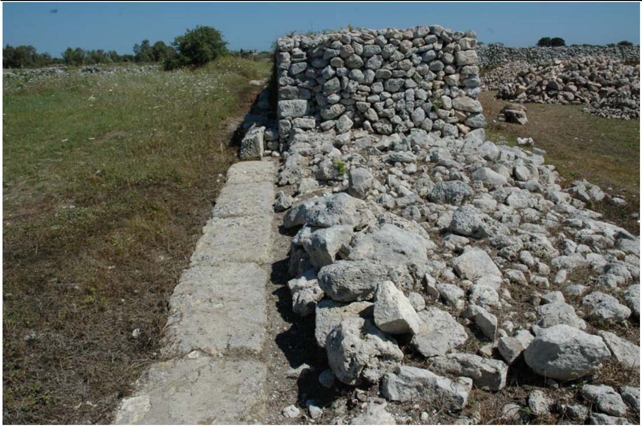
Figura 6-192 Opere murarie della masseria fortificata di pozzo seccato
