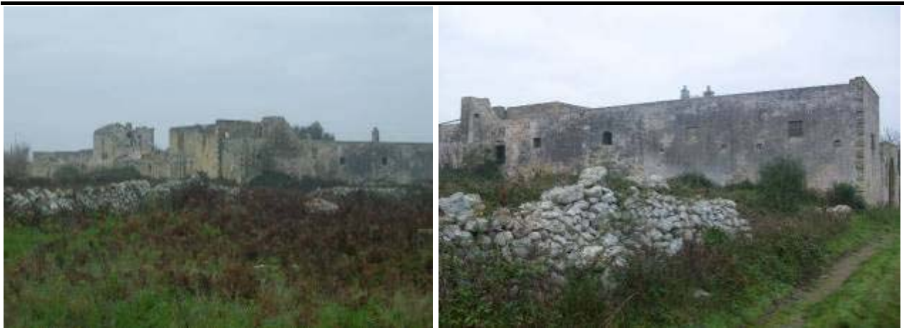
Figura 6-170 Masseria “Coviello” (Disabitato, Edificio storico in pietra)
