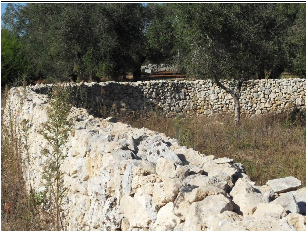
Figura 8-23 Muretto a Secco che Delimita un Lotto di Terreno nell’ Area di Studio (Kp 4.5)
