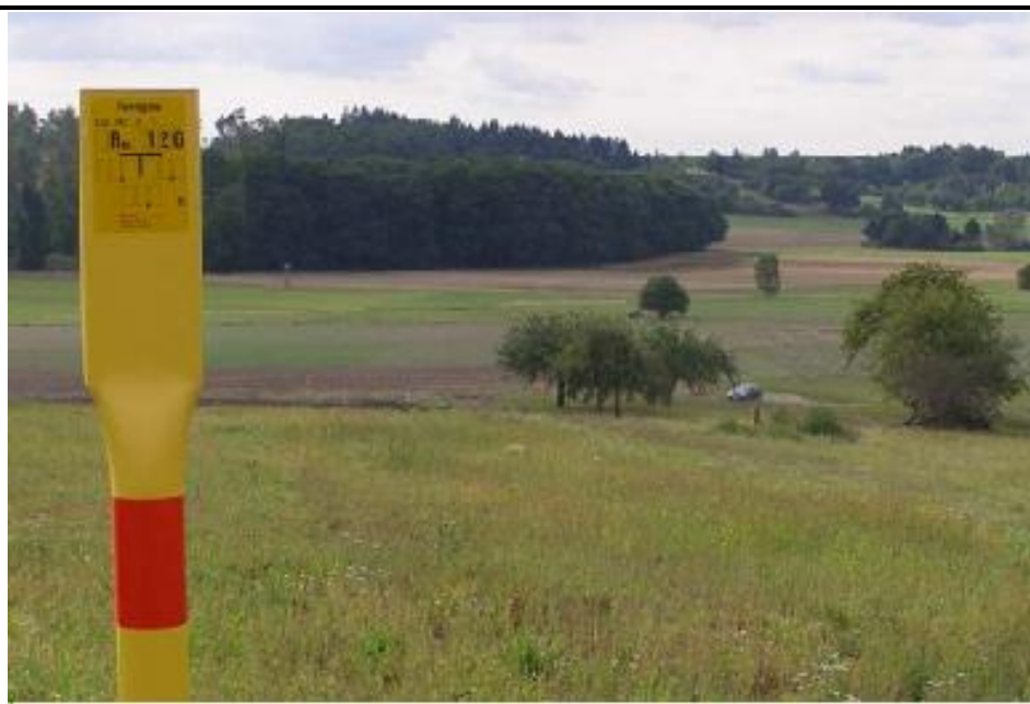
Figura 8-14 Esempio di un Gasdotto in seguito dei Lavori di Ripristino
