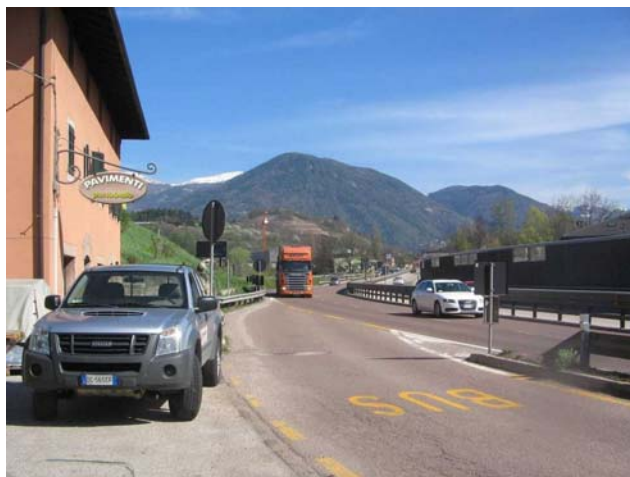
Figura 15: la S.S. 47 in un tratto ammodernato con la commistione di diverse funzioni: fermata della linea bus, attività alberghiera a ridosso della sede stradale, con ridotta o assente corsia di decelerazione
