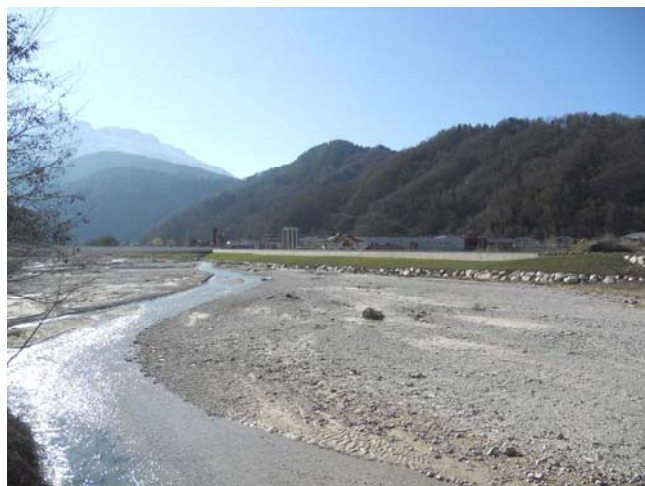
Figura 18: il torrente della val di Centa con in lontananza il nuovo viadotto che collega le due sponde
