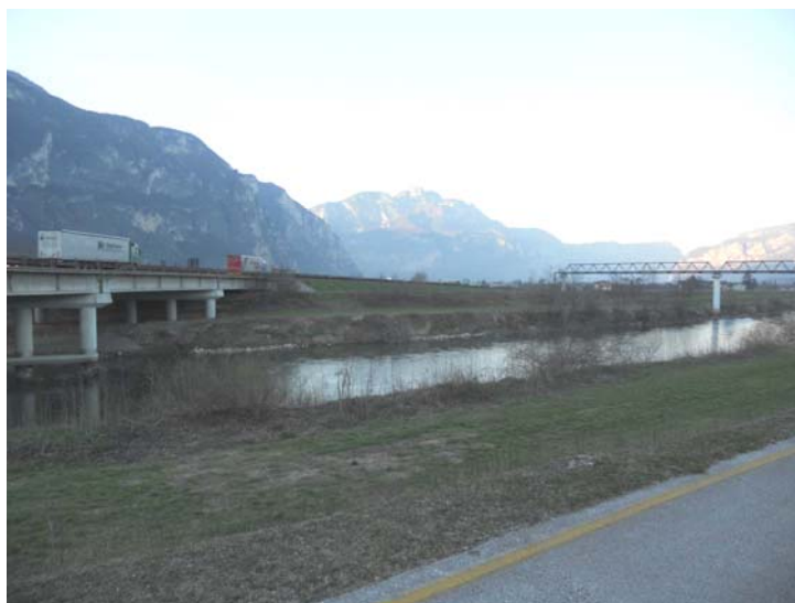
Figura 13: la zona dell'interconnessione con la A22 a Lavis, dalla quale si evince la presenza del viadotto autostradale (A22) sull'Adige, il ponte tubo di un metanodotto e la pista ciclabile arginale
