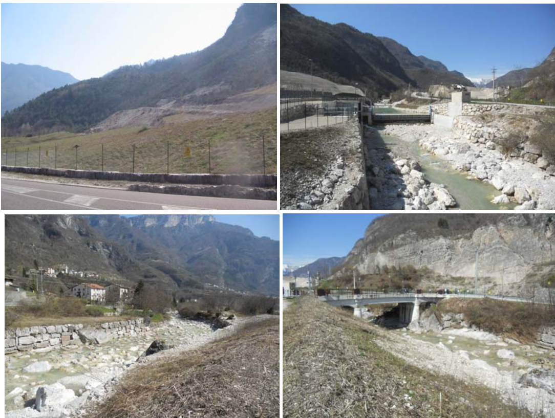
Figura 12: all'uscita della galleria S. Pietro si trova un pendio recentemente rimodulato, il sito della cava con un sostegno per produzione idroelettrica ed il torrente Astico canalizzato
