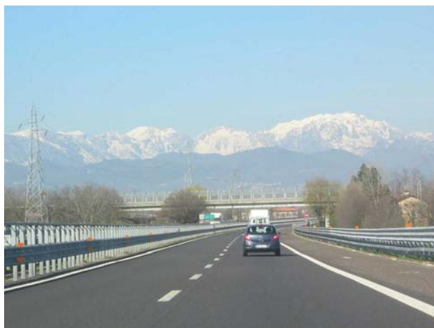
Figura 1: foto del tratto esistente della A31
