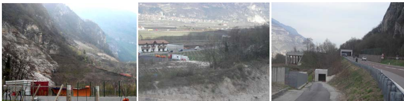
Figura 20: l'area di interconnessione con la A22: il versante della montagna lungo il quale il tracciato si adagia prima dell'imbocco, la zona di svincolo e il tratto di SS12 e ferrovia da superare in viadotto
