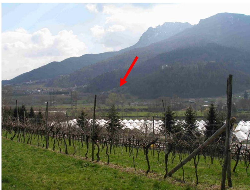
Figura 8-5. Sbocco della galleria S. Vito e valle del Torrente Fersina.
