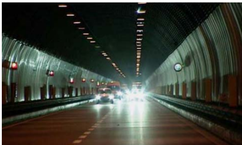
Figura 6: la galleria Piè di Castello sulla A22, con sezione stradale senza la corsia di emergenza
