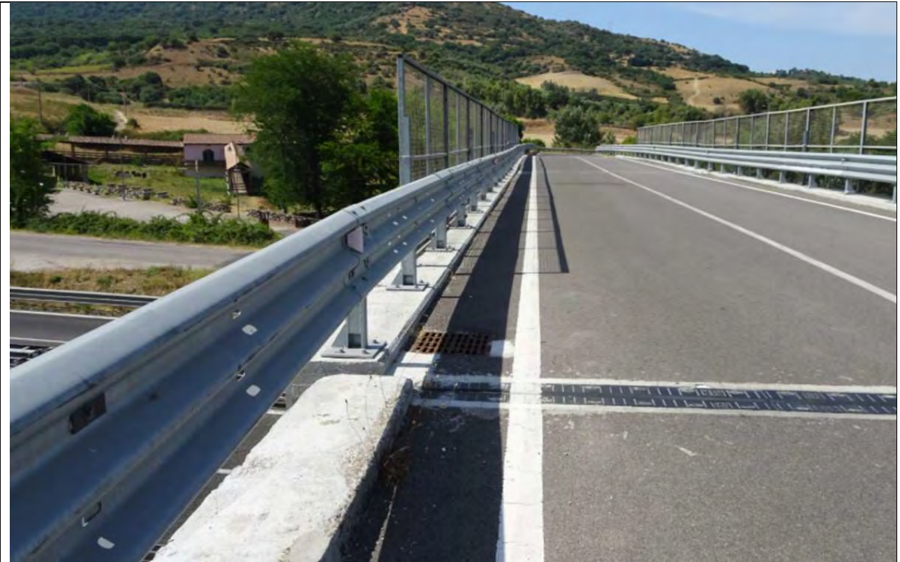
Situazione alla data del collaudo
