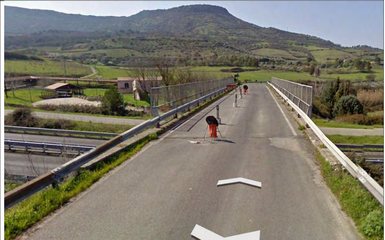
Situazione alla data del rilievo
