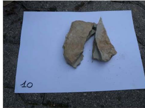
Dopo la rottura
