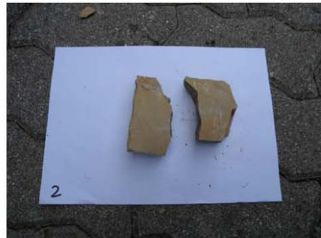
Dopo la rottura
