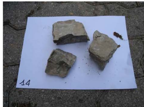
Dopo la rottura
