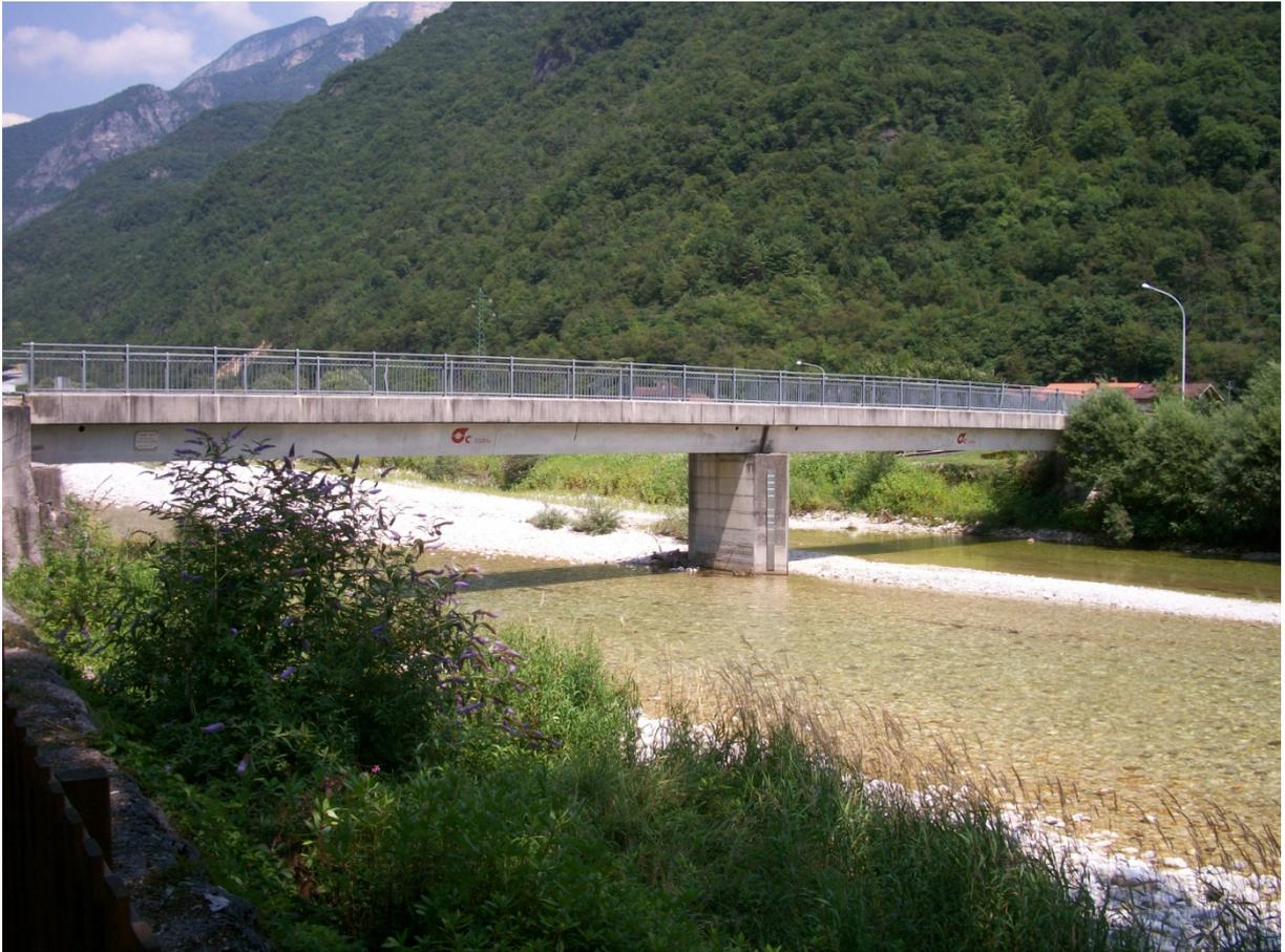
Figura 31 Torrente Astico – tratto 3. Ponte con pila in alveo
