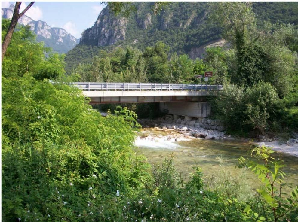
Figura 42 Torrente Astico – tratto 5. Ponte con rivestimento sezione con massi
