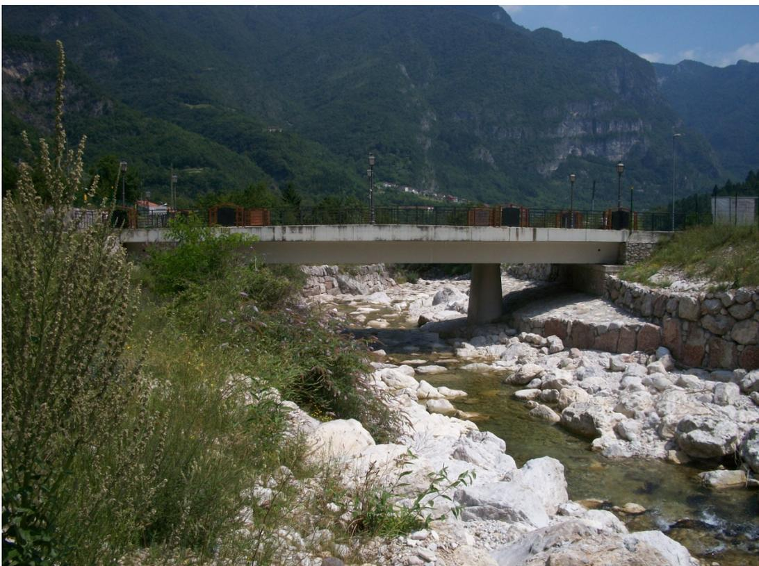
Figura 21 Torrente Astico – tratto 2. Ponte con pile in alveo
